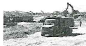
Camiones de volteo, con apoyo de grúas, retiran grandes cantidades de tierra.
