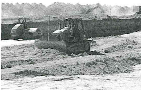
Con maquinaria pesada retiran una capa del terreno para la cimentación.
