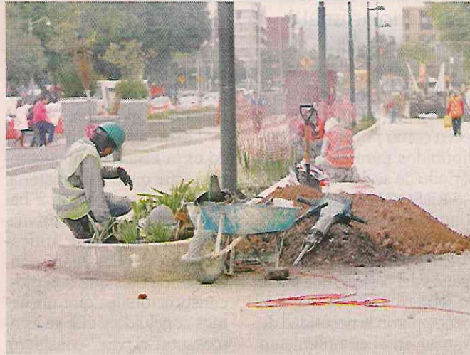
■ Aún se realizan trabajos en jardineras de la vialidad.
