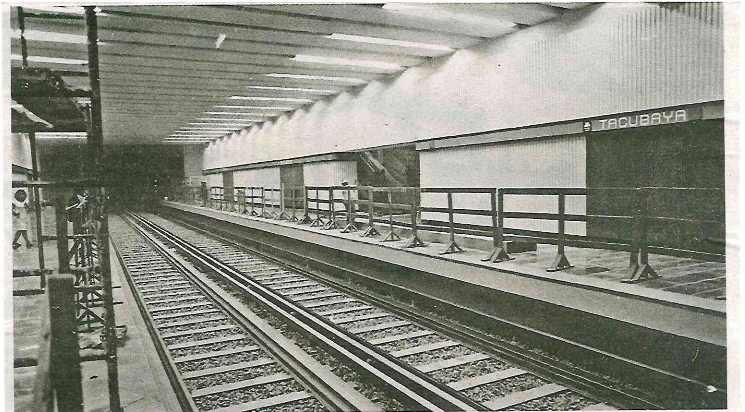
Ampliación de la línea 1 (noviembre de 1970).
