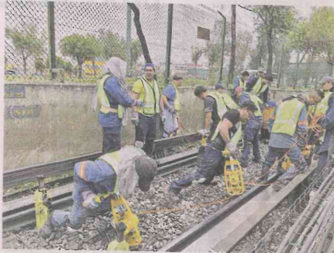
■ El Metro indicó que el mantenimiento a la vía será constante para que opere en óptimas condiciones.
