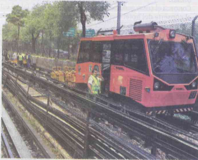
Las obras son para renivelar un tramo de 1.2 kilómetros lineales en las vías, permitirá a los usuarios realizar sus viajes más rápido.
