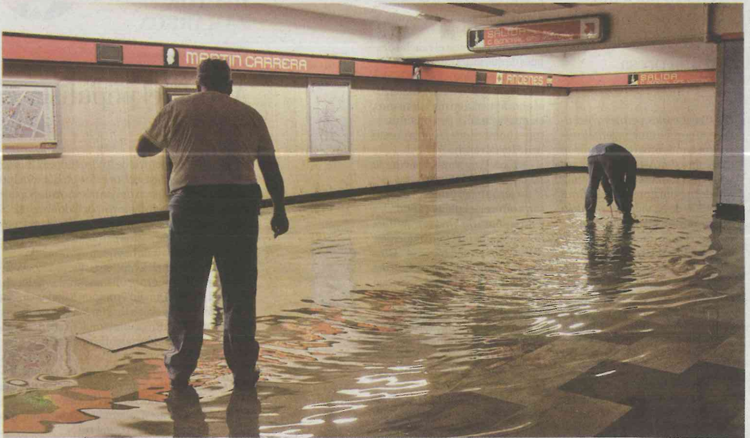
Durante la temporada de lluvias algunas estaciones sufren inundaciones. JUAN CARLOS BAUTISTA
