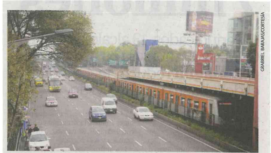
Vista actual de la estación Viaducto del Metro sobre calzada de Tlapan. Del lado derecho al fondo, aún se ve la “loma” de esta larga vía.
