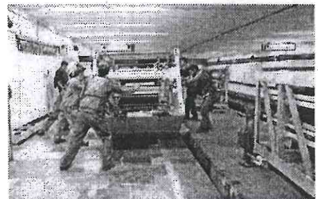
Una plataforma de 20 metros de largo y capacidad de carga de 69 toneladas se utiliza para el traslado de escaleras eléctricas.
