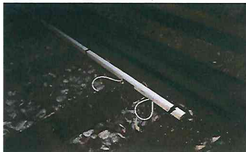
Tapiz madera instalado en cambio de vía
