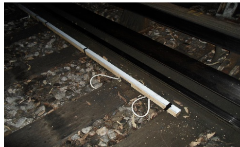
Tapiz madera instalado en cambio de vía
