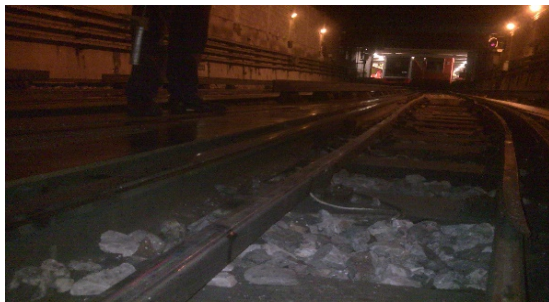
Tapiz Madera instalado en terminales
