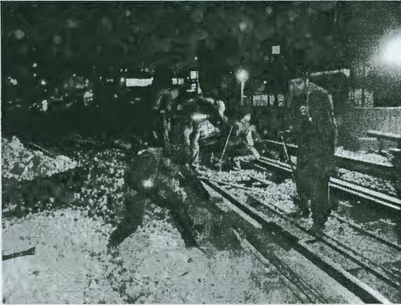
Nivelación de vía en la zona de junta ubicada en el P.K.8+090, entre las estaciones Terminal Aérea y Oceanía
