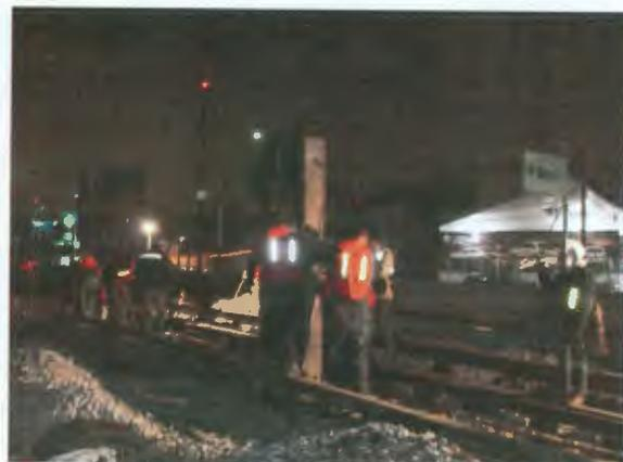
Nivelación de vía en la zona de junta ubicada en el P.K.8+090, entre las estaciones Terminal Aérea y Oceanía
