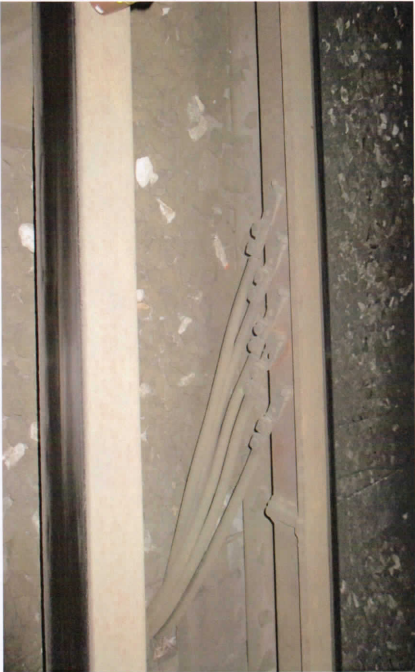
Foto No. 27.- Se ven los cables de tracción, siendo conectadas a la barra guía.
