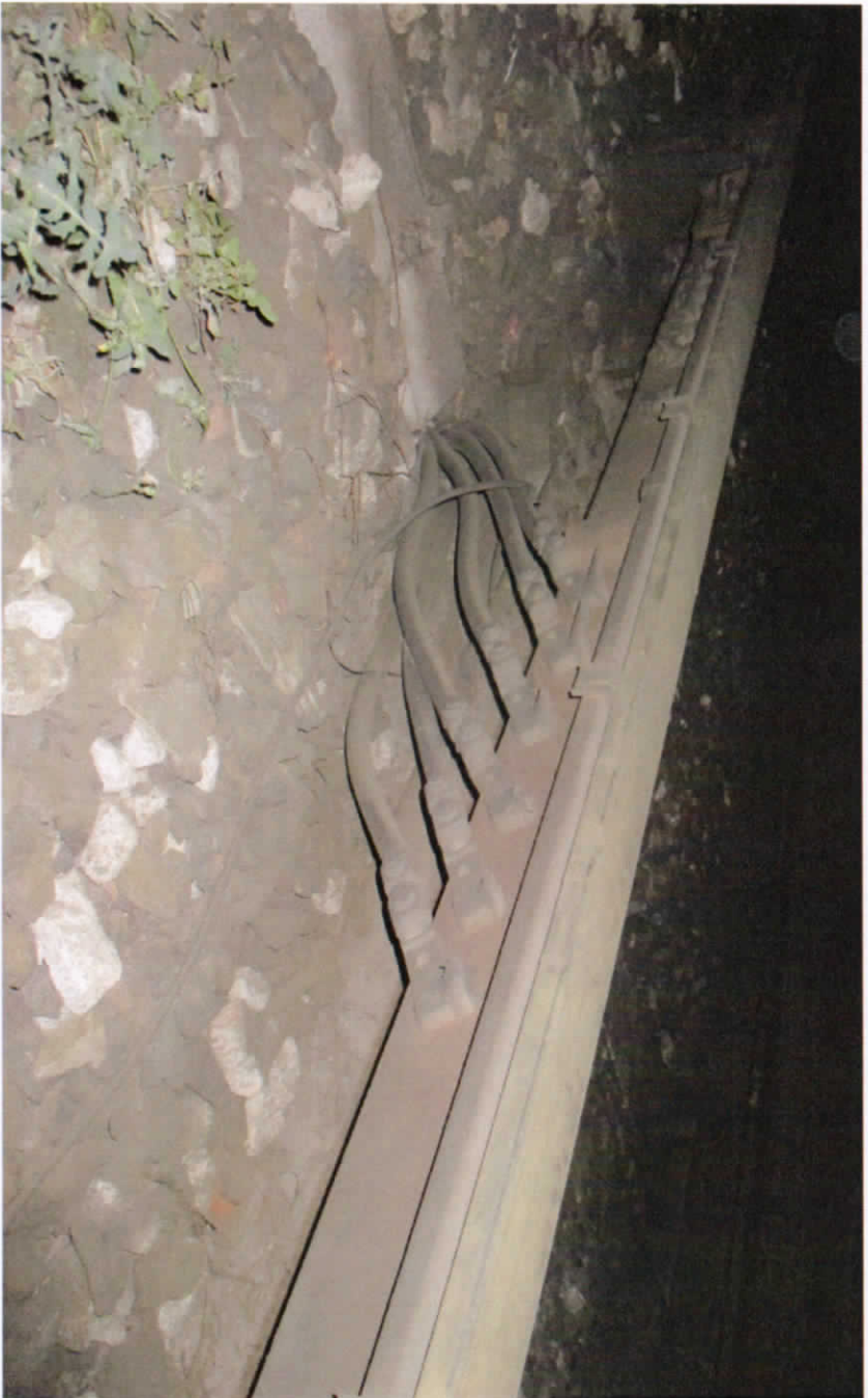
Foto No. 28.- Otra vista de los cables de tracción conectados a la barra guía.
