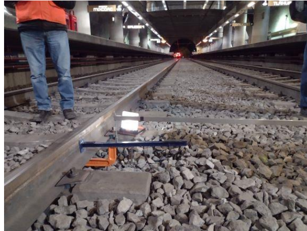
Soporte ya instalado en el alma
