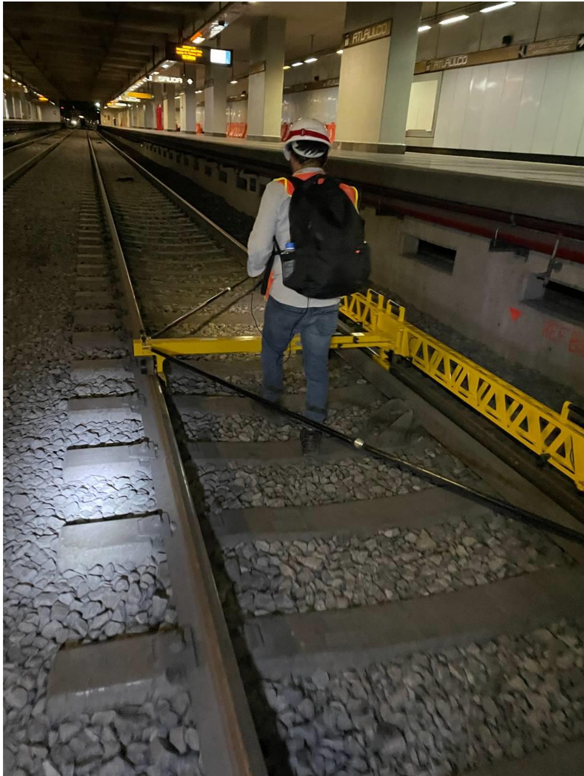
Figura 138. Estación Atlalilco se mide la vía 1 en dirección a Mixcoac.
