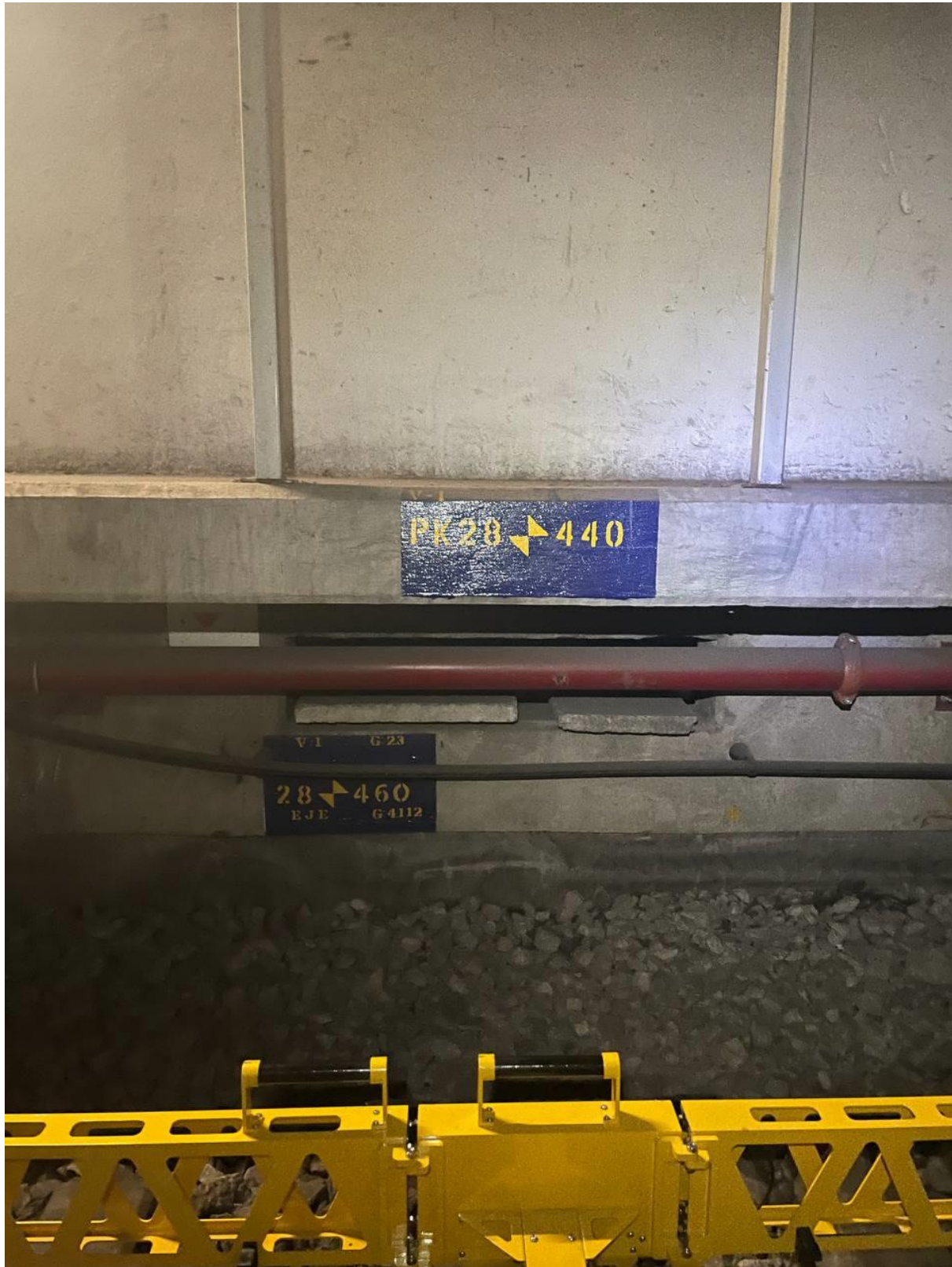
Figura 143. Se presentan Diferencias en los cadenamientos marcados en el trayecto en ambas vías.
