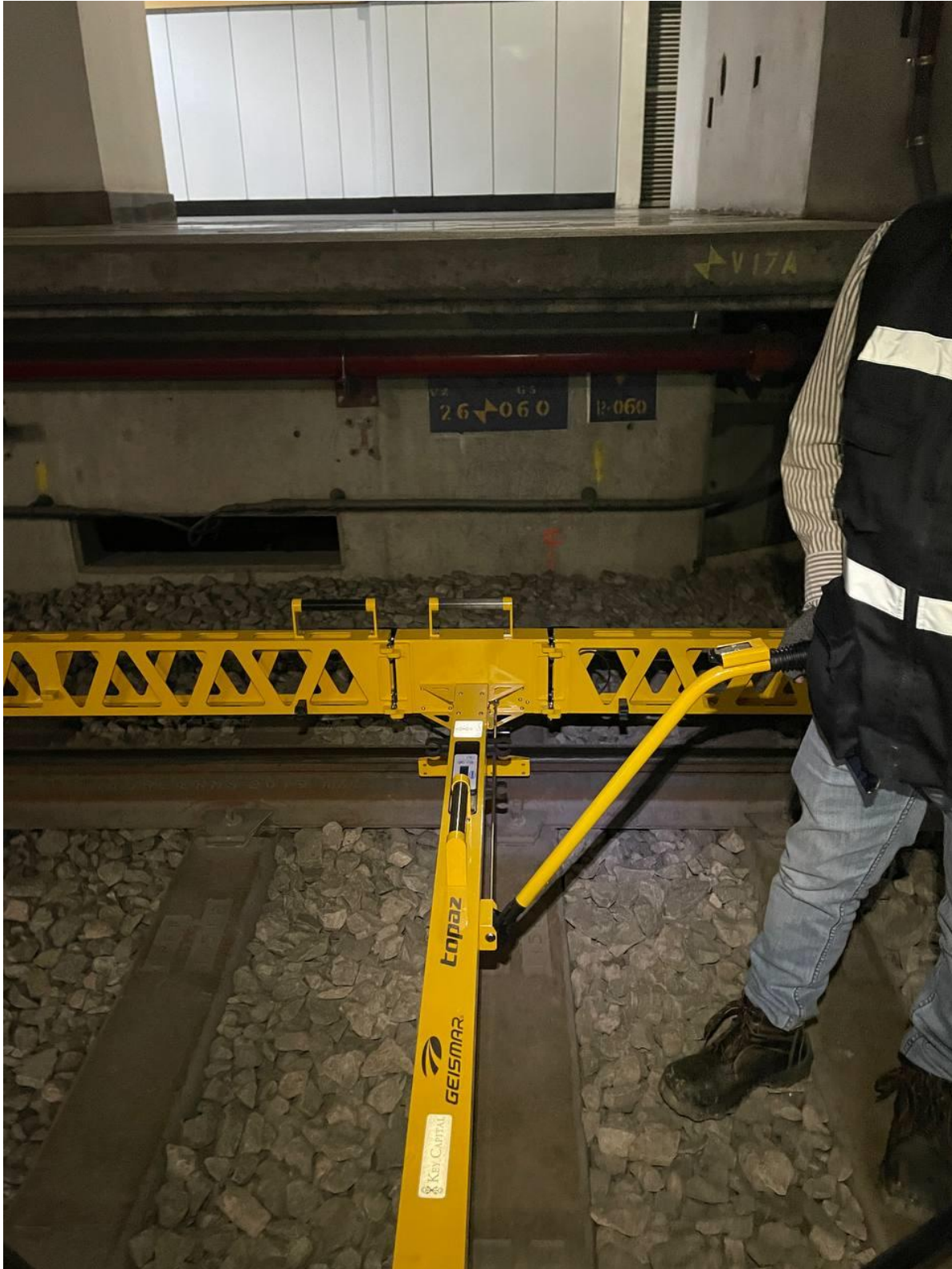
Figura 152. Inicio de nuevo trabajo, se calibra el equipo antes, en un tramo recto en estación.
