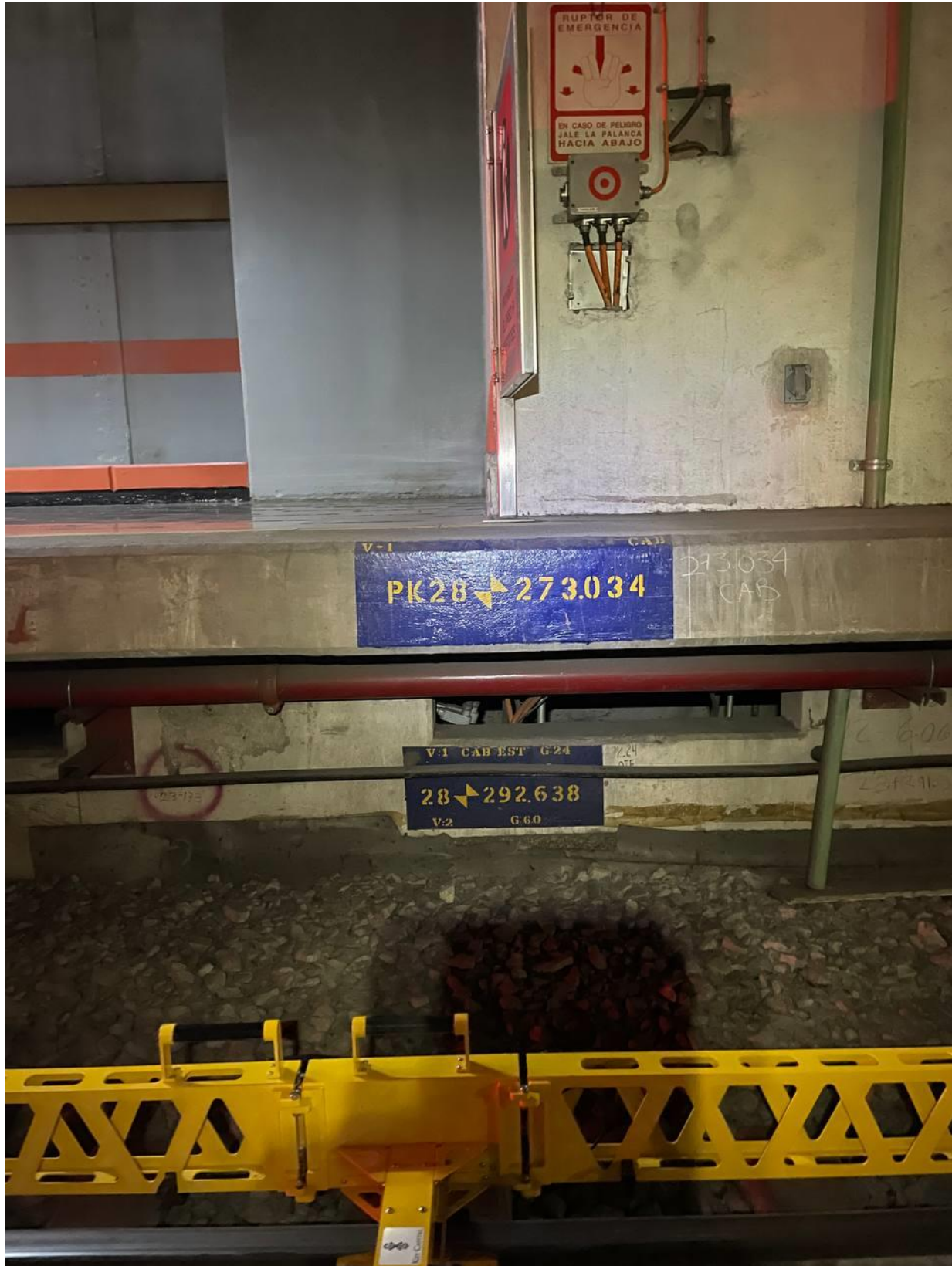
Figura 140. Inicio de Trabajo en el Cadenamiento 28+273 en vía 1.
