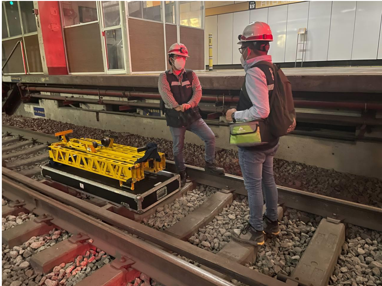
Figura 150. Platica de seguridad en sitio, antes de iniciar trabajos en Estación Atlalilco.
