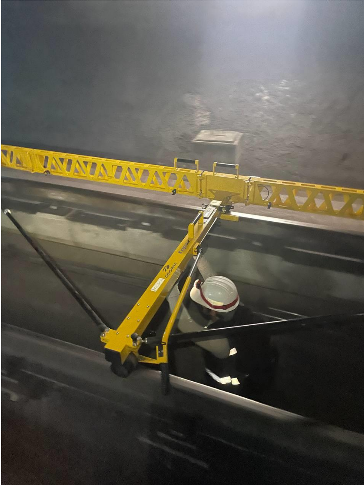
Figura 144. En la cola de la Estación Mixcoac, se tiene un canal entre los rieles.
