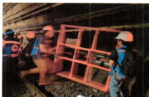
Fig. 2 Instalación del marco rectangular.
