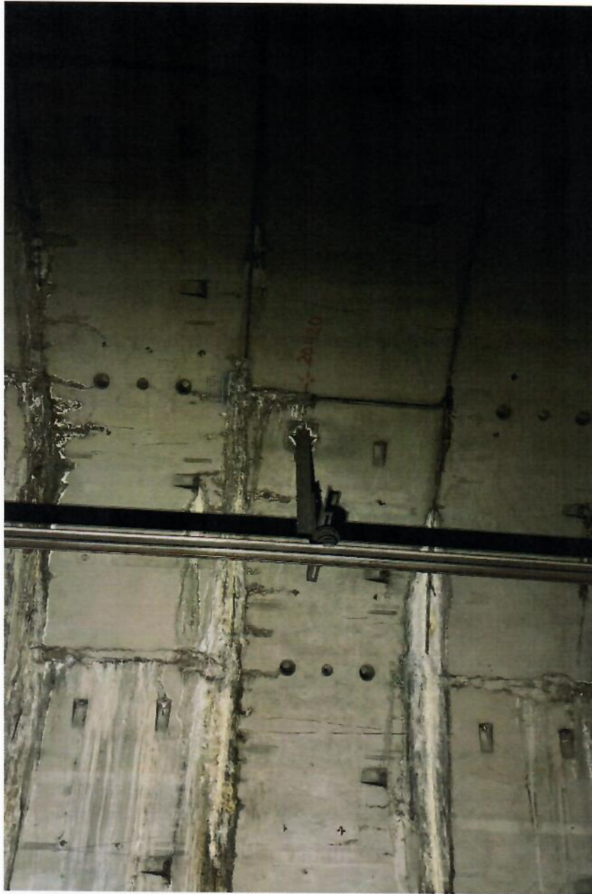
Fotografía 9. Filtraciones a la altura del cadenamiento 20+120 en zona de catenaria.
