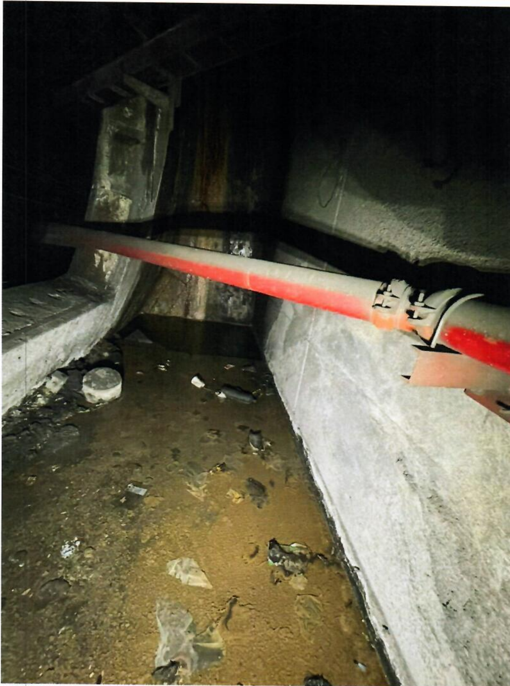
Fotografía 19. Acumulación de agua en fosa lateral izquierda al túnel a la altura del cadenamiento 20+340, se observa un constante escurrimiento de agua en las paredes del cajón.
