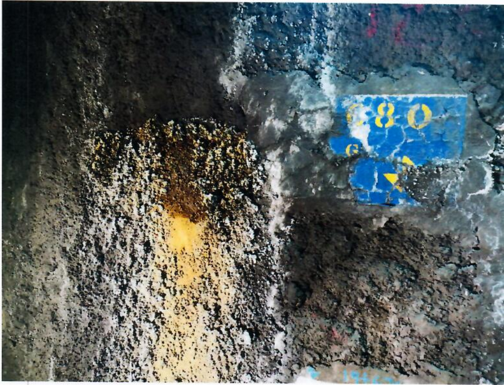
Fotografía 21. Degradación del concreto
