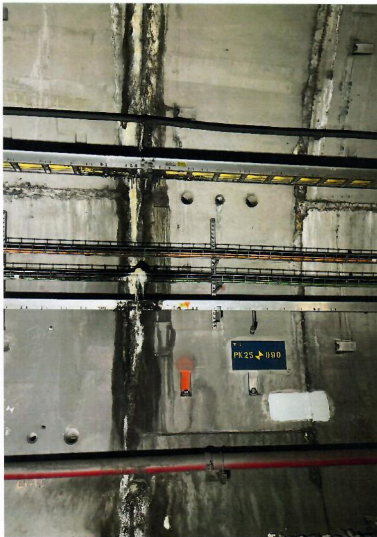
Fotografía 6. Filtraciones a la altura del cadenamiento 25+090. Se observa que la presencia de filtraciones en esta zona está dañando las instalaciones electromecánicas.
