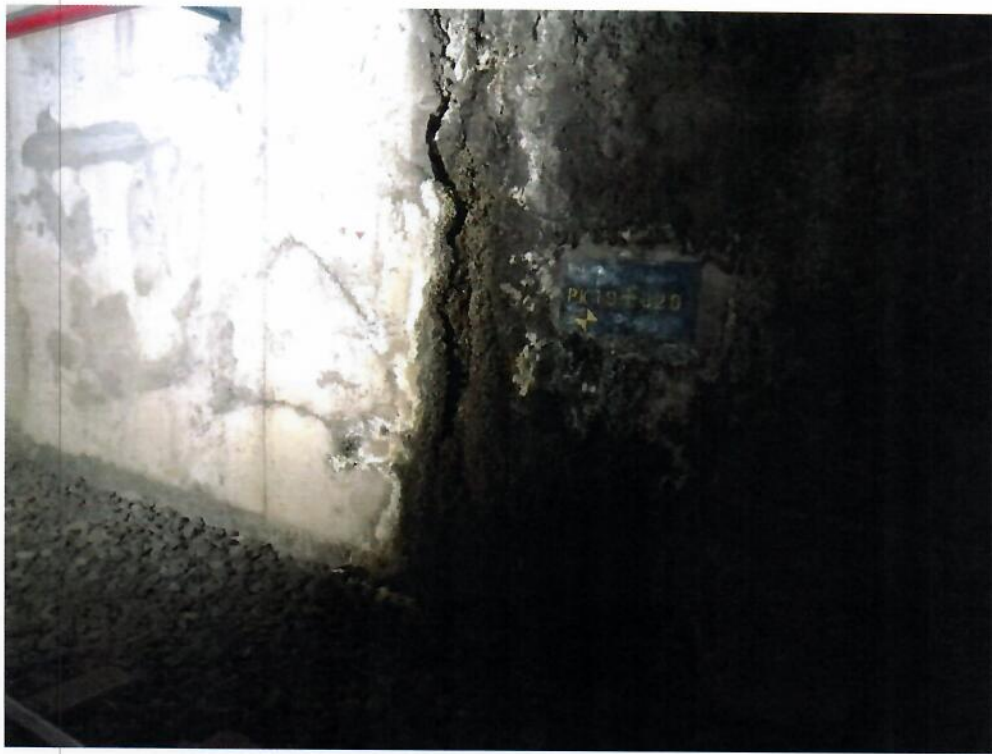
Fotografía 20. Estado actual del túnel en el cadenamiento 19+820.
