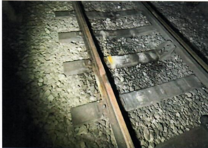
Fotografía 2. Daños causados por filtraciones, se observa la acumulación de sales sobre un durmiente a la altura del cadenamiento 24+500.
