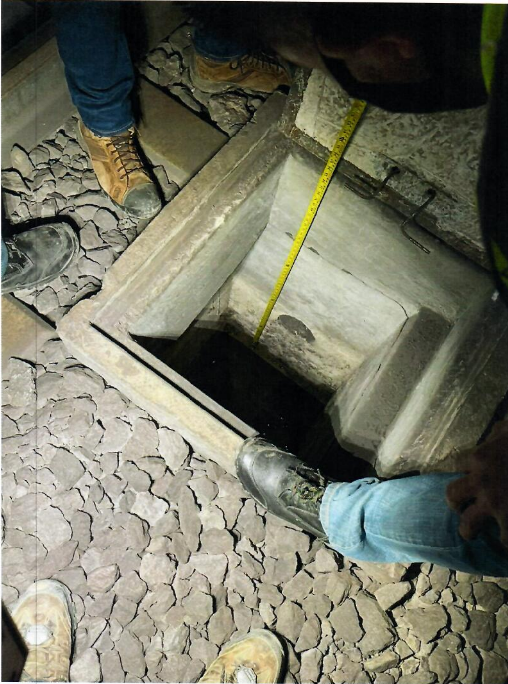
Fotografía 11. Disposición inadecuada de las tuberías ubicadas en el registro que comunica el sistema hidráulico del túnel con el cárcamo de bombeo.
