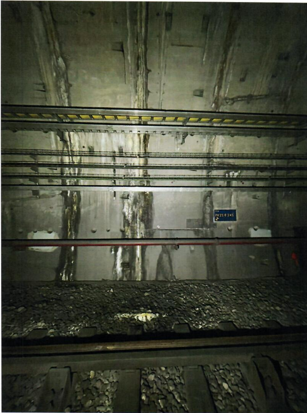
Fotografía 4. Presencia de filtraciones a la altura del cadenamiento 25+245
