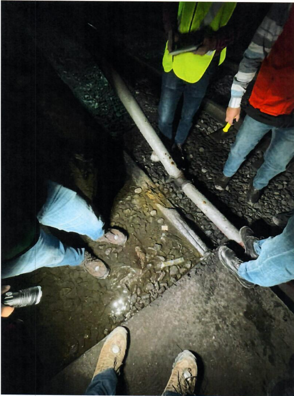
Fotografía 18. Erosión en el balasto de la vía y en el bordillo perimetral provocado por el constante flujo que ha tenido el agua hacia el interior del túnel.
