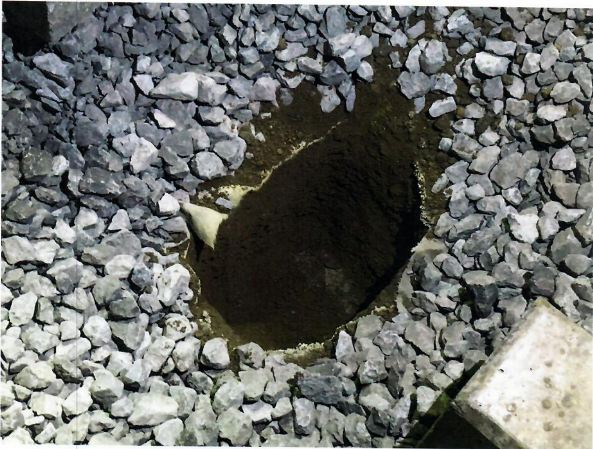
Figura 17. Cala C-13, realizada en el tramo Ermita - Mexicaltzingo, cadenamamiento 21+160.
