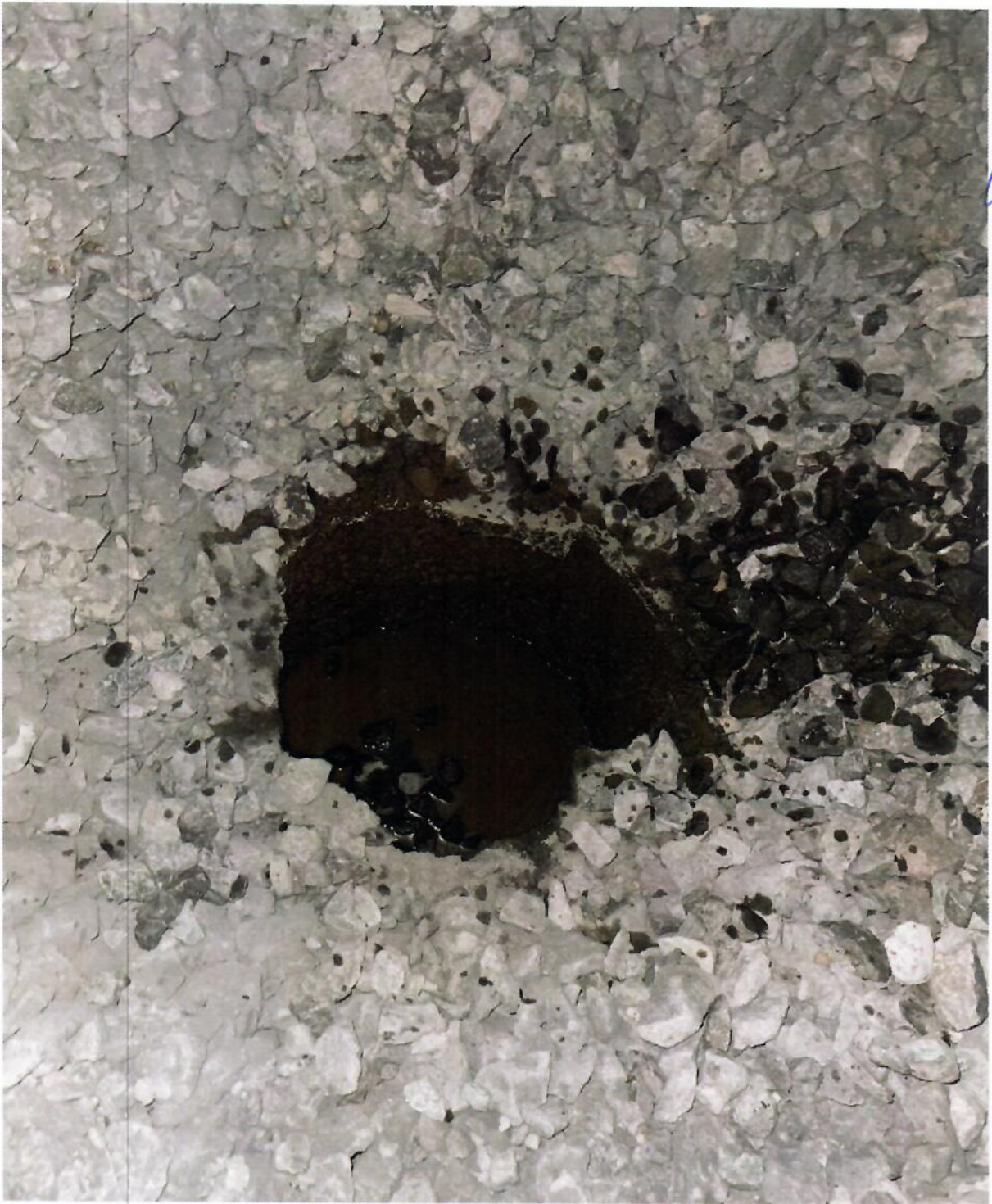
Figura 6. Cala C-2, realizada en el tramo Parque de los venados – Eje central, cadenamiento 25+197.
