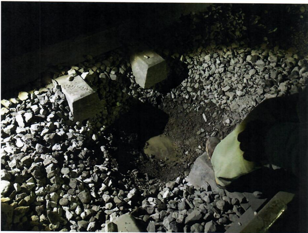
Figura 19. Cala C-15, realizada en el tramo Mexicaltzingo - Atlalilco, cadenamiento 20+380.
