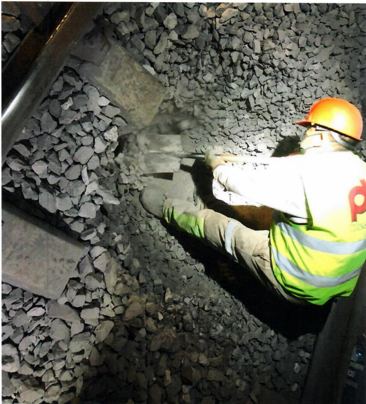
Figura 15. Cala C-11, realizada en el tramo Ermita - Mexicaltzingo, cadenamamiento 22+180.
