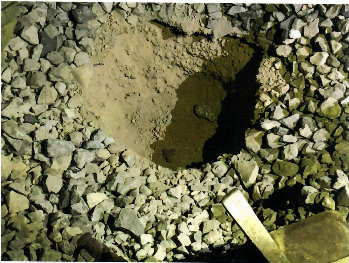
Figura 16. Cala C-12, realizada en el tramo Ermita - Mexicaltzingo, cadenamamiento 21+855.
