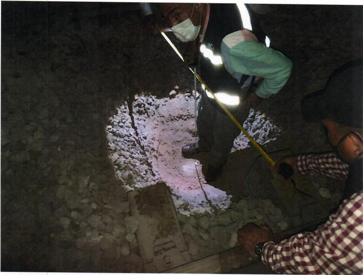
Figura 14. Cala C-10, realizada en el tramo Ermita - Mexicaltzingo, cadenamiento 22+531.
