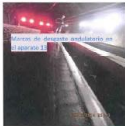
Foto 34: Desgaste ondulatorio – Aparato de vía 13/23
