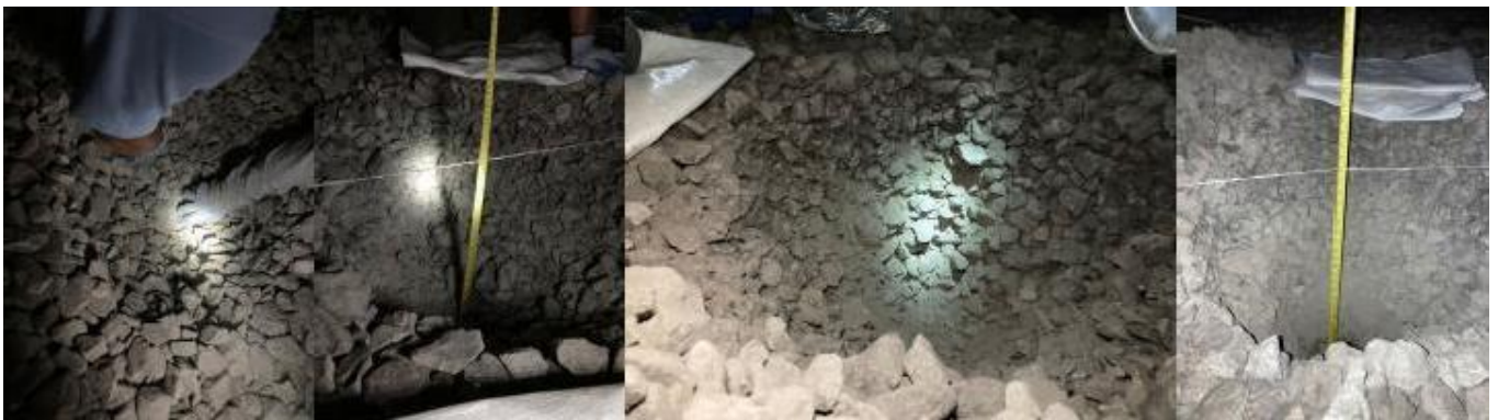
Figura 11. Sondeo del cadenamiento 27+340, inter-estación Insurgentes Sur-20 Noviembre.
