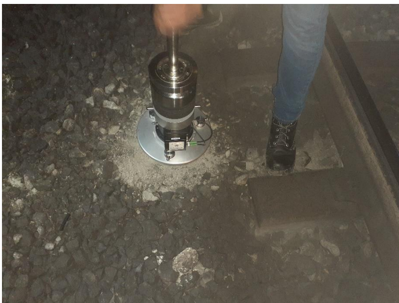
Figura 14 Pruebas con LWD en zona de transición cadenamiento 20+345.
