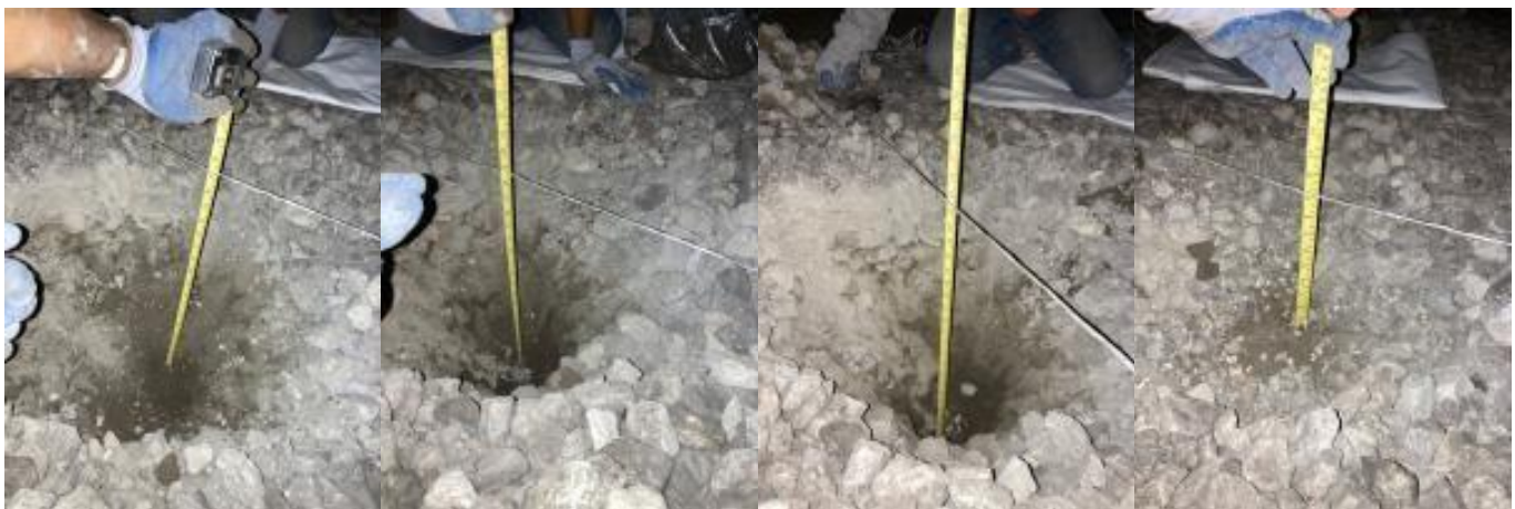
Figura 17. Sondeo realizado en el cadenamiento 20+345, inter-estación Mexicaltzingo-Atlalilco.
