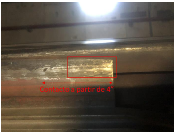
Brillo por contacto excesivo de la ceja de la rueda con la punta de agujas, la cual debe iniciar su Contacto 4" después de la punta.
