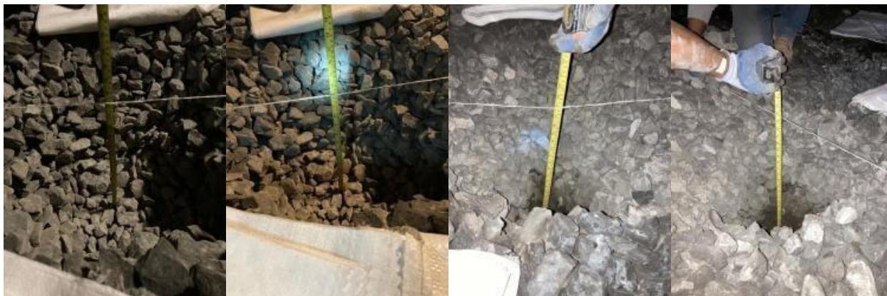
Figura 18. Sondeo realizado en el cadenamiento 20+345, inter-estación Mexicaltzingo-Atlalilco.
