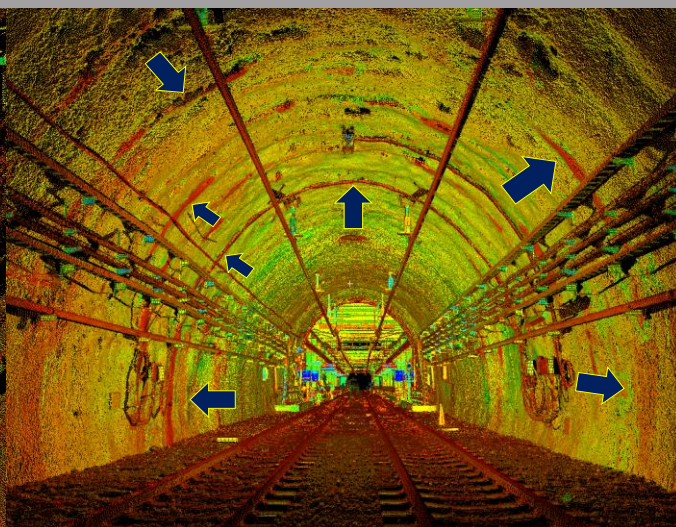
ZONA DE FILTRACIÓN 10 Cad. N/A tramo Mixcoac – Insurgentes Sur
