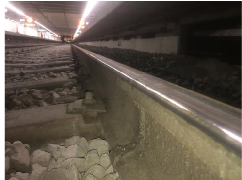
No hay cuatrapeo en las soldaduras y algunas ya presentan desprendimientos de metal en la banda de rodamiento.
