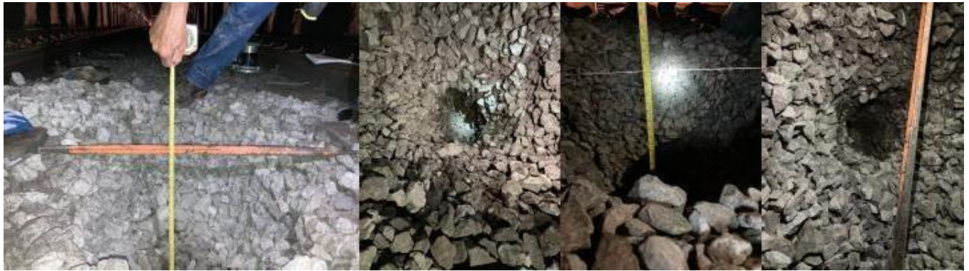
Figura 10. Sondeo del cadenamiento 28+060, inter-estación Mixcoac-Insurgentes Sur.
