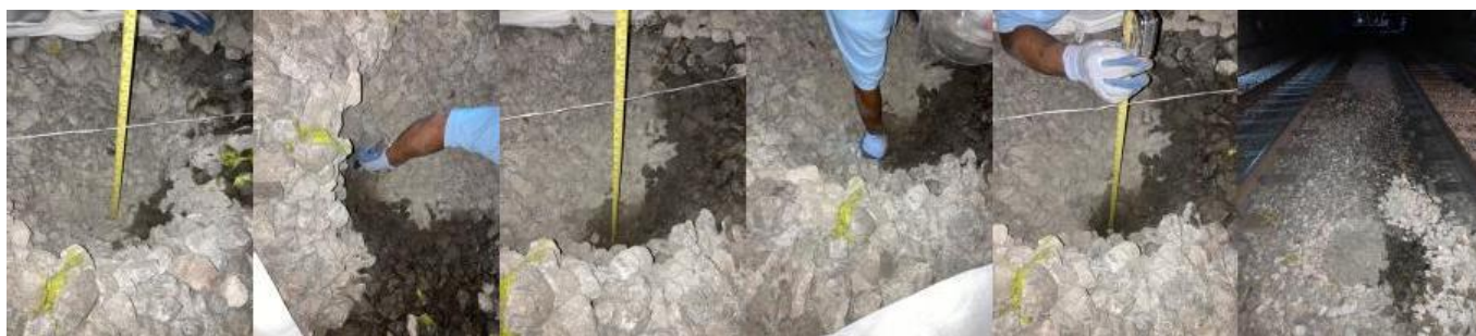
Figura 13. Sondeo correspondiente al cadenamiento 25+470, inter-estación Zapata-P. Venados.
