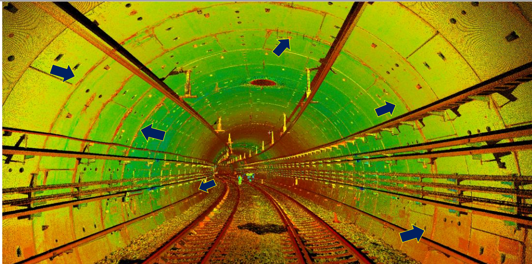
ZONA DE FILTRACIÓN 1 Cad. PK. 25+805 tramo Zapata – Parque de los Venados
