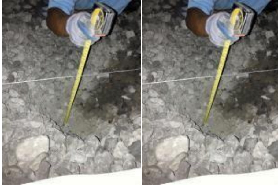
Figura 16. Fotografías del pozo del cadenamiento 21+030, inter-estación Ermita-Mexicaltzingo.
