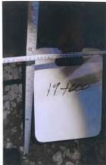
Foto 23. Balasto con mucha humedad (P+19+600)
