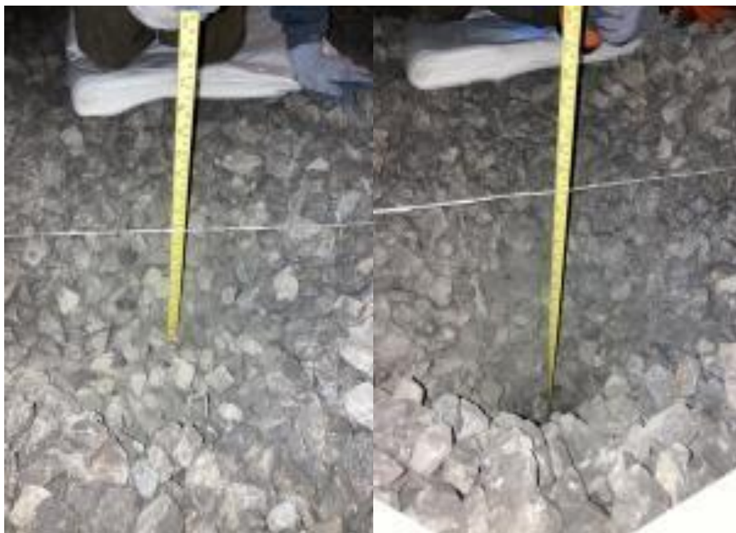
Figura 15. Sondeo correspondiente al cadenamiento 23+597, inter-estación Eje Central-Ermita.
