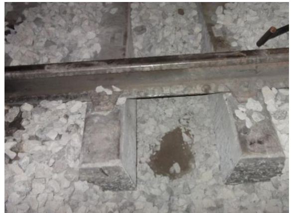
Ilustración 1 Balasto fuera de especificación, con humedad permanente, degradado y fuera de granulometría
