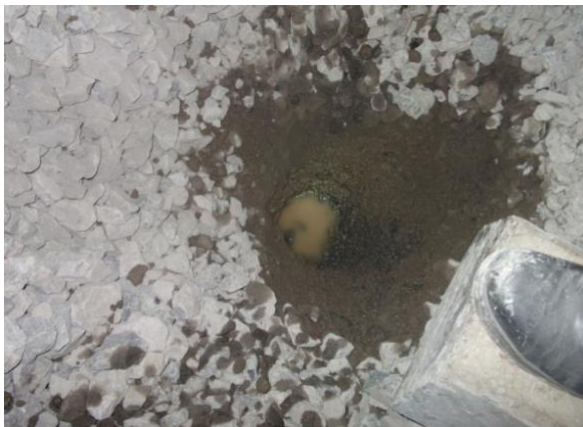
Ilustración 1 Balasto fuera de especificación, con humedad permanente, degradado y fuera de granulometría
