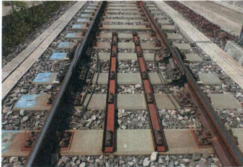
**Figura 47: Ejemplo de aparatos de dilatación en línea 12**
