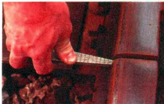
**Figura 11: Registro de la abertura; para las JA, colocar la galga sin forzar entre un extremo y el perfil aislante**
