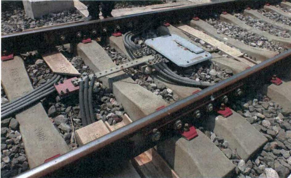
**Figura 14: Junta Aislante Pegada**
