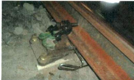
Poner el riel en vibraciones desde el corte, a medida de la progresión del desenganche, sobre toda la longitud de la parte del riel a liberar.
