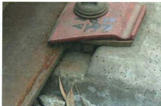
**Figura 10: Fijación del riel es de tipo Nabla Evolución**
