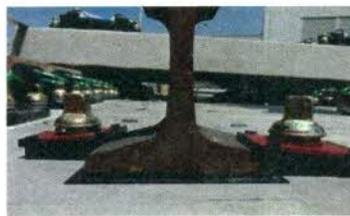
**Figura 15: Fijación del riel de seguridad sobre los soportes – foto Línea 12**
