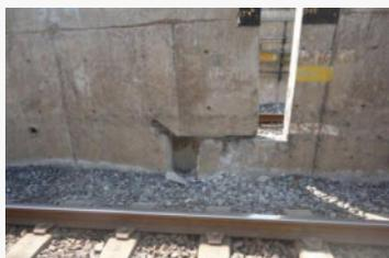
JUNTA ABIERTA CON DEFORMACIÓN DE MUROS
