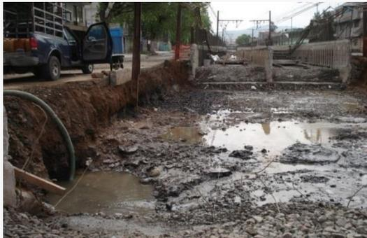
DEMOLICIÓN DEL CAJÓN ESTRUCTURAL, PREVIO RETIRO DE LAS INSTALACIONES DE VÍAS, ELÉCTRICAS Y ELECTRÓNICAS.
