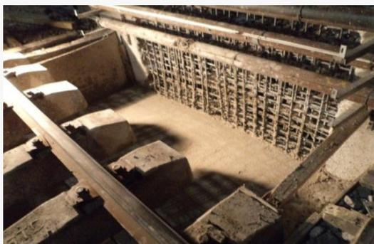
COLOCACIÓN DE CONCRETO PARA RECONSTRUCCIÓN DE LOSA DEL CAJÓN ESTRUCTURAL. SE OBSERVA TAMBIÉN EL ARMADO DEL MURETE CENTRAL DEL CAJÓN.
