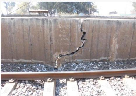
FRACTURA EN MURO DEL CAJÓN ESTRUCTURAL
