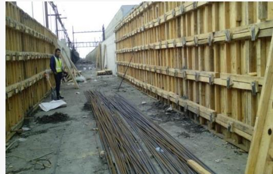
RECONSTRUCCIÓN DEL CAJÓN ESTRUCTURAL. SE OBSERVA COLOCACIÓN DE ACERO DE REFUERZO PARA RECONSTRUCCIÓN DE LA LOSA Y MUROS.
