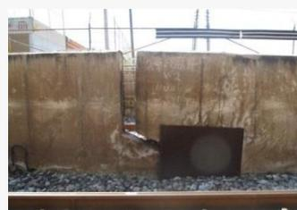
JUNTA ABIERTA CON DEFORMACIÓN DE MUROS
