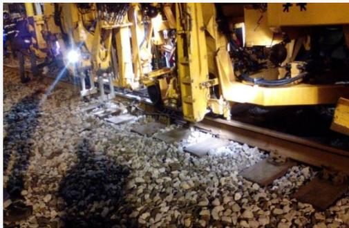
CORRECCIÓN DEL PERFIL DE LA VÍA CON MÁQUINA MULTICALZADORA.
