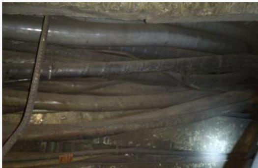
CABLES DE ALTA TENSIÓN OBSOLETOS Y ENVEJECIDOS QUE PROPICIAN FALLAS EN LOS CIRCUITOS ALIMENTADORES DE ALUMBRADO Y FUERZA Y SUBESTACIONES DE RECTIFICACIÓN, REDUCIENDO LA FIABILIDAD EN LA CIRCULACIÓN DE LOS TRENES.
