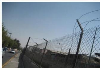
MALLA CICLÓN SOBRE MURO DE CONFINAMIENTO DE LA LÍNEA, CON ESCASA ALTURA Y CON ALAMBRE DE PUAS ROTO
