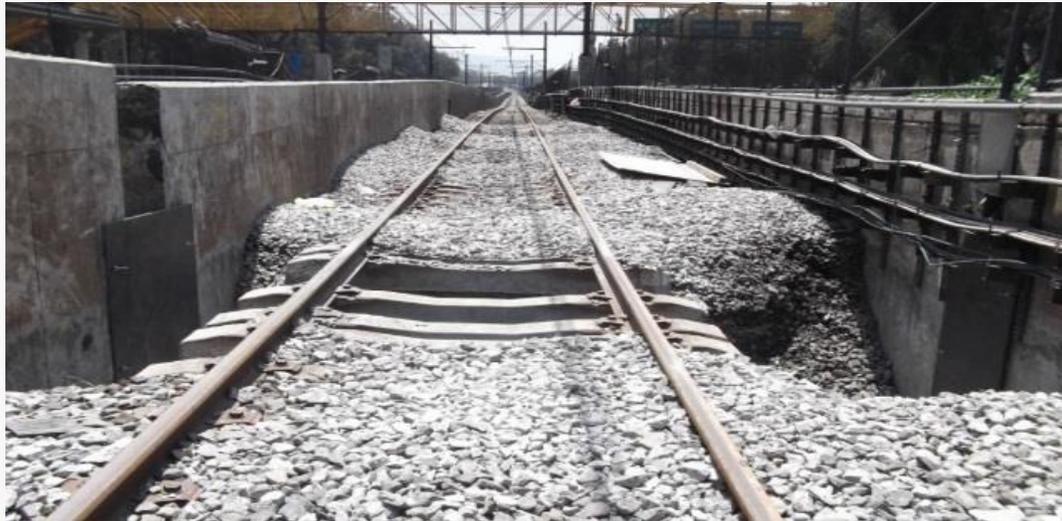
COLOCACIÓN DE TAPAJUNTAS DE ACERO PARA EVITAR
