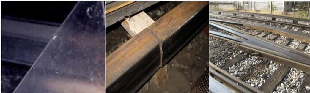
DESGASTE EN SECCIÓN TRANSVERSAL DEL PERFIL DE BARRA GUÍA; FRACTURAS DE BARRA GUÍA EN SOLDADURAS ALUMINO-TÉRMICAS DERIVADO DE LA FATIGA Y REDUCCIÓN DE LA SECCIÓN TRANSVERSAL Y DURMIENTES EN ZONA DE APARATOS DE CAMBIO DE VÍA CON ALTO GRADO DE DETERIORO.
