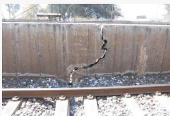
FALLA ESTRUCTURAL EN MURO EN EL P.K. 12+430,
