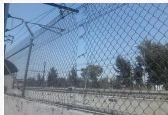
MALLA CICLÓN COLOCADA SOBRE MURO DE CONFINAMIENTO DE LA LÍNEA EN MAL ESTADO
