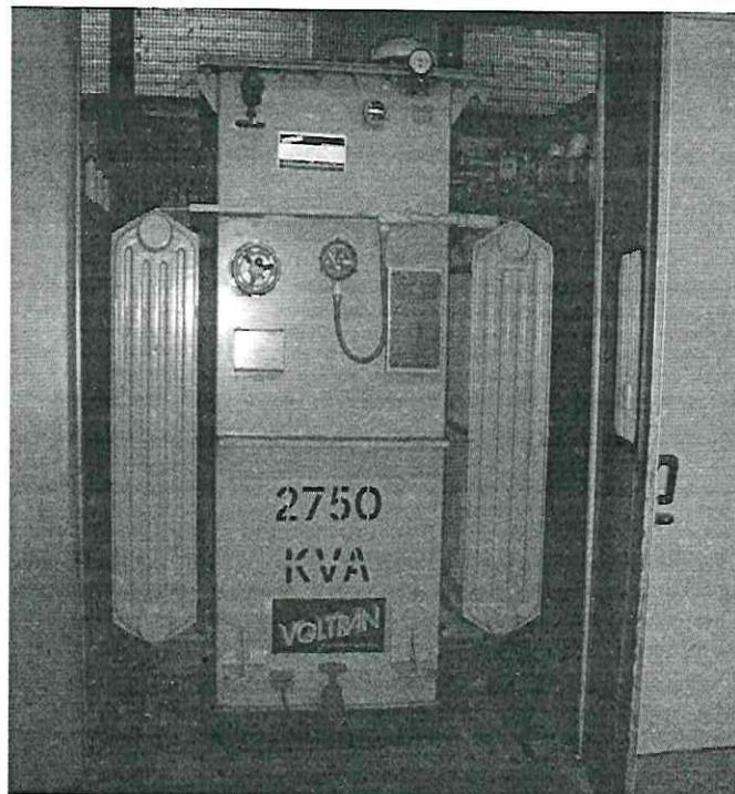
Transformador de potencia de 2750 KVA 15,000 volts de las Subestaciones de Rectificación de Línea 1.
