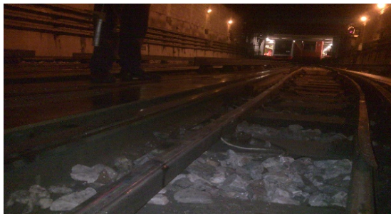
Tapiz Madera instalado en terminales
