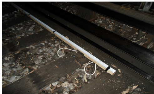
Tapiz madera instalado en cambio de vía
