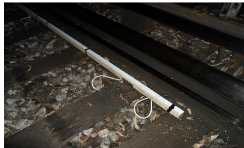
Tapiz madera instalado en cambio de vía
