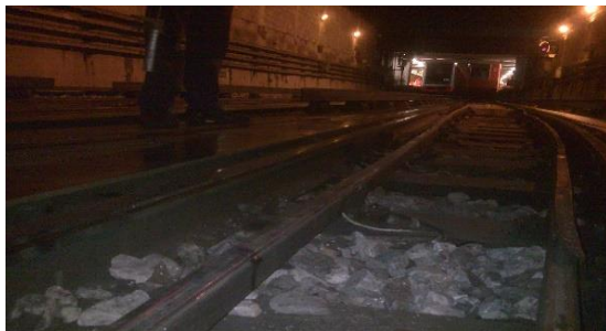
Tapiz Madera instalado en terminales
