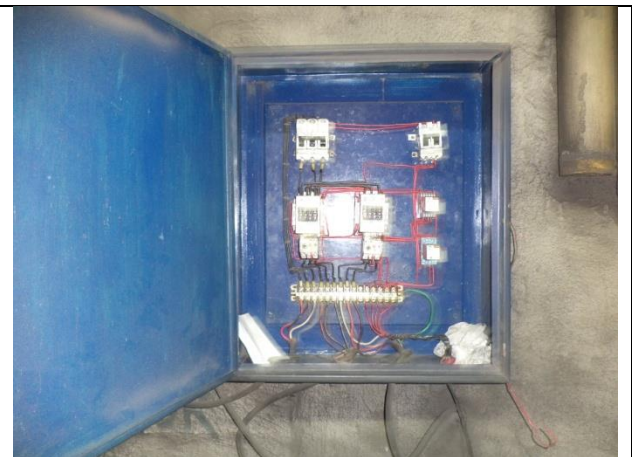
Sustitución del tablero de control y fuerza
