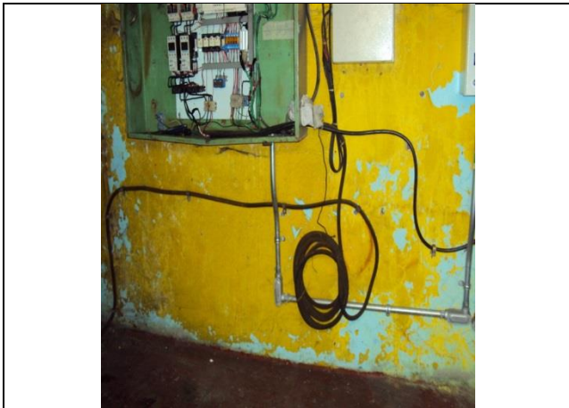
Sustitución de tablero de control y fuerza, tuberías conduit que alojan cables de fuerza y control, así como los ductos cuadrados de cables a la llegada del tablero
