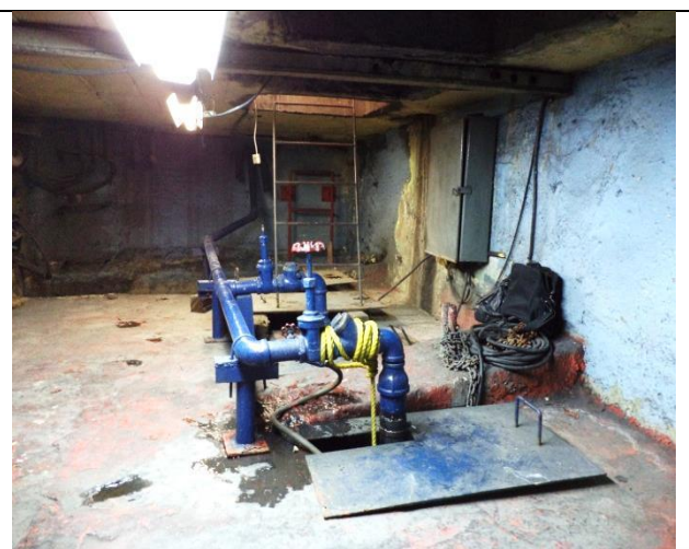
Sustitución de arreglo hidráulico.
