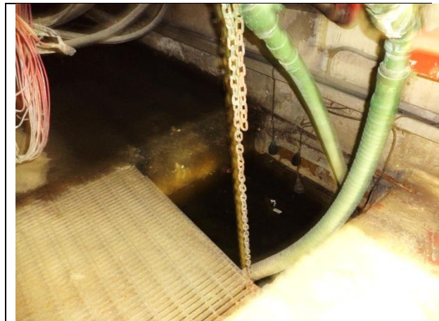
Sustitución de: mangueras; soportes para tuberías de descarga y arreglo hidráulico; marcos y rejilla irving
