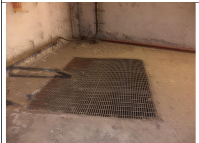
Instalación de escalera de acceso del cuarto de maquinas
