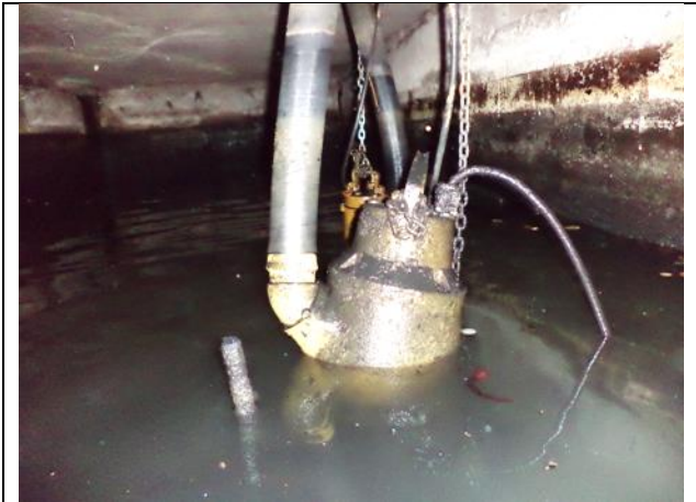
Sustitución de motobombas
