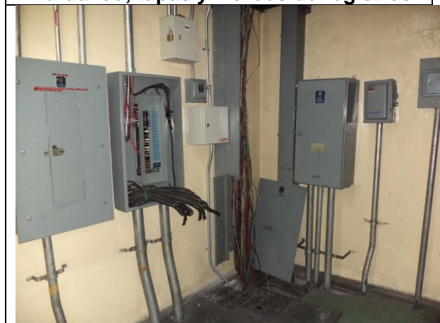
Sustitución de los cableados de alimentación trifásica a 220 volts, más un hilo de tierra, desde la subestación eléctrica hasta el tablero de control y fuerza.
