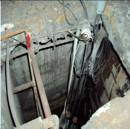
Sustituir escalera marina y gancho para soporte de electrodos
