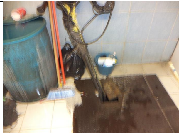
Sustitución de la motobomba, instalando dos equipos de bombeo, así como la tapa y marco del registro pasa hombre de acceso al cárcamo
