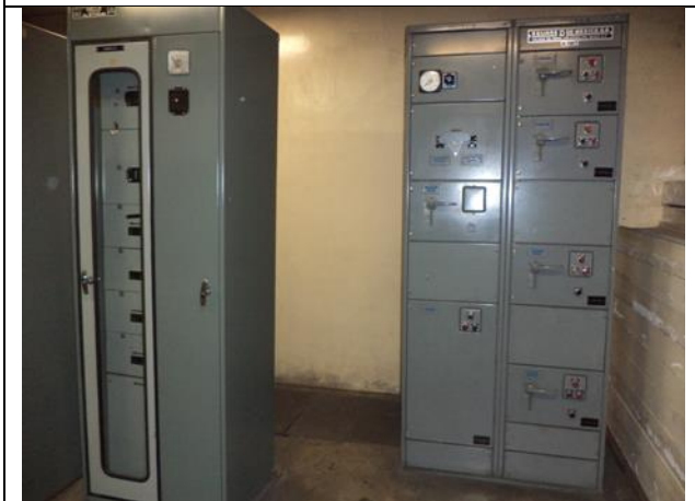
Sustitución del centro de control de motores y transferencia automática en la subestación eléctrica, instalando un tablero de distribución en donde se encuentren todos los interruptores de los equipos de bombeo de la estación "TABLERO F", con alimentación PREFERENCIAL.
