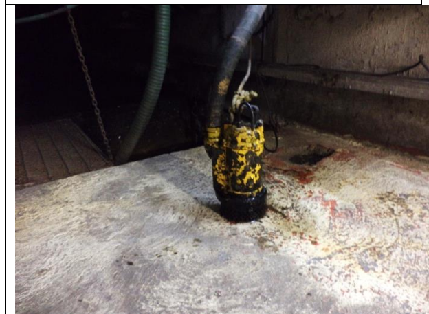
Sustitución de motobombas
