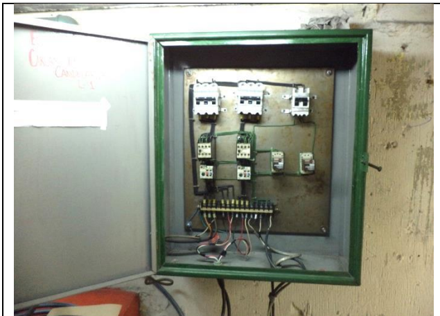
Sustitución de tablero de control y fuerza
