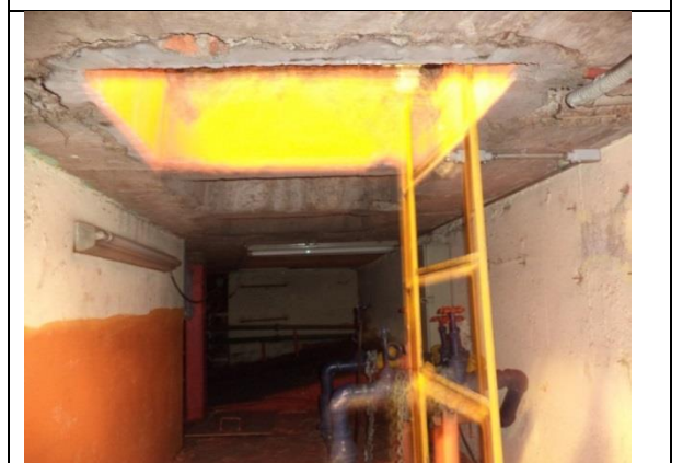
Sustitución de las tapas y marcos del acceso a la sala de máquinas, así como de la escalera marina.
