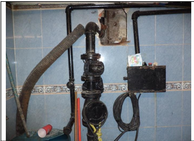
Sustitución de las tuberías de descarga y arreglo hidráulico
