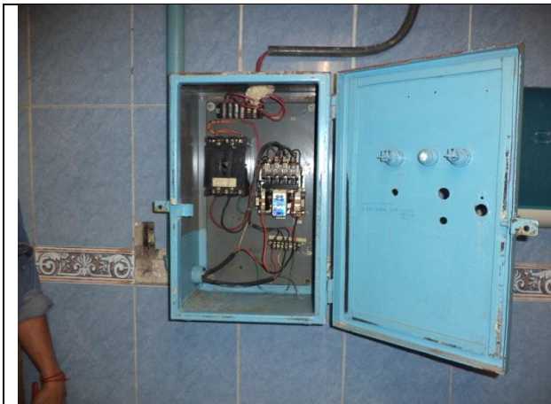
Sustitución del tablero de control y fuerza
