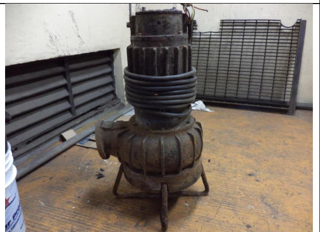
Sustitución de equipo de bombeo, rejillas no visión, rejillas Irving.
