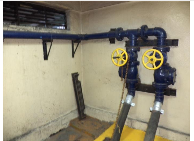
Sustitución de arreglo hidráulico
