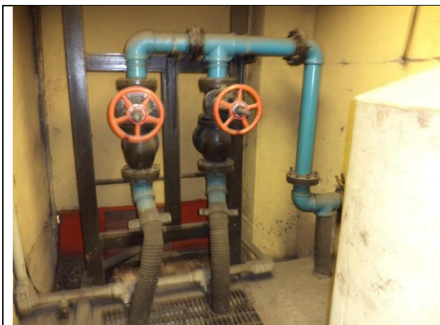
Sustitución de arreglo hidráulico y mangueras de descarga
