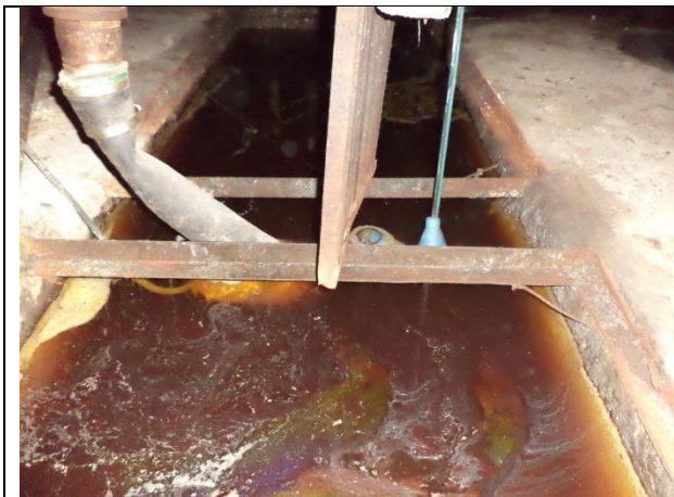
Sustitución de marcos y rejillas irvingro así como cadena soporte
