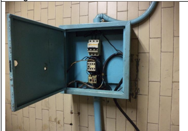
Sustitución del tablero de control y cableado eléctrico
