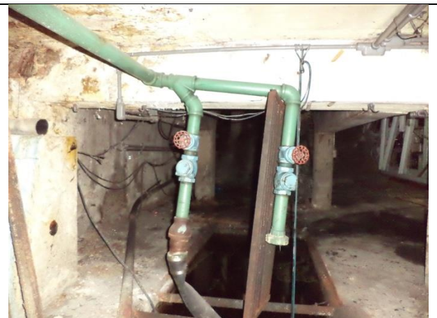
Sustitución de arreglo hidráulico. soporteria
