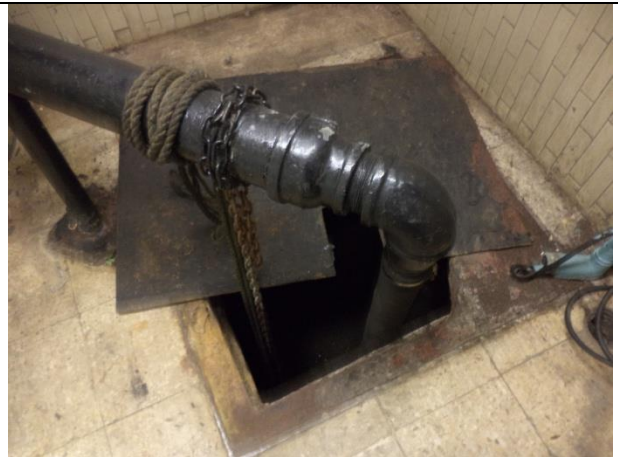
Sustitución de marcos y tapas de registro asi como cadena soporte
