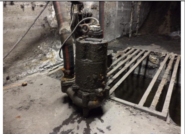
Sustitución de motobombas, mangueras, rejilla
