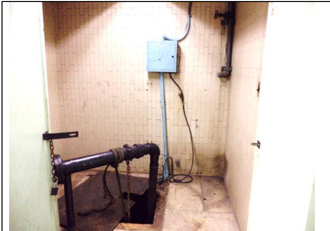
Sustitución de arreglo hidráulico, mangueras de succión cadenas
