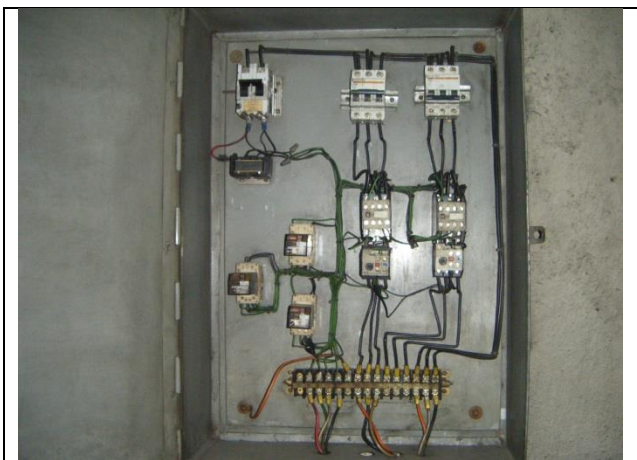
Sustitución del tablero de control y fuerza
