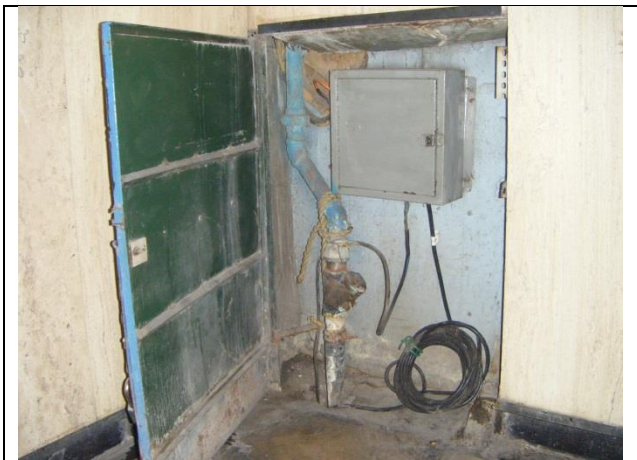
Sustitución del tablero de control y fuerza
