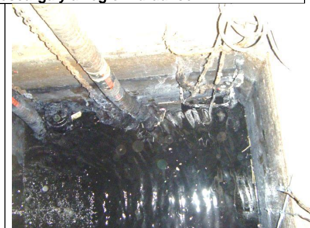
Sustitución de las dos motobombas
