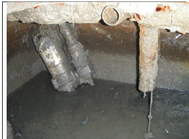
Sustitución de la motobomba
