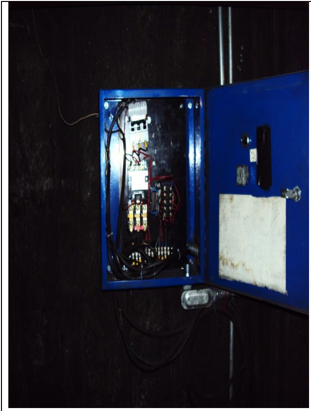
Instalación actual de tablero de control y equipo e bombeo en registro de canal cubeta
