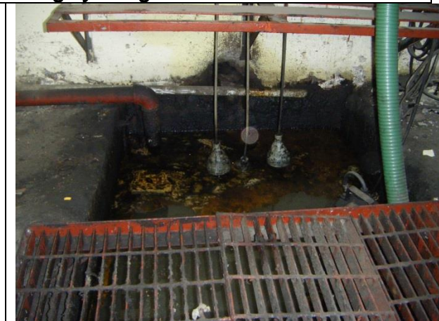
Sustitución de rejilla Irving y marco soporte del cárcamo.
