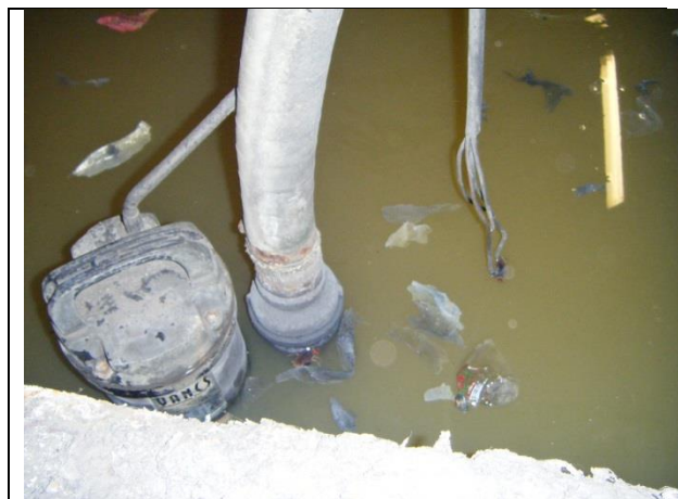
Sustitución de las dos motobombas
