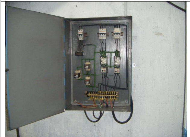
Sustitución del tablero de control y fuerza
