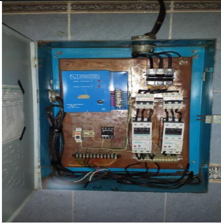
Sustitución de tablero de control y fuerza
