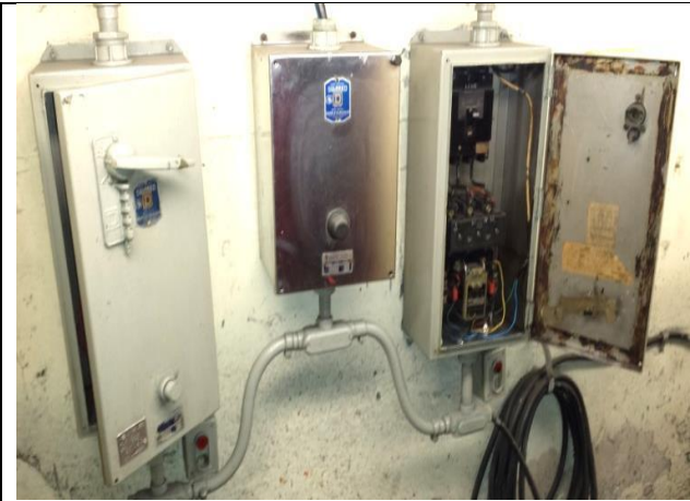
Sustitución de tablero de control y fuerza
