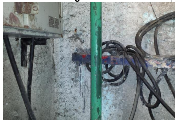
Sustitución de los cableados de alimentación trifásica a 220 volts, más un hilo de tierra, desde la subestación eléctrica hasta el tablero de control y fuerza.
