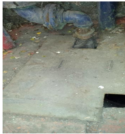
Sustitución de: mangueras; soportes para tuberías de descarga y arreglo hidráulico; tapas y marcos de registros
