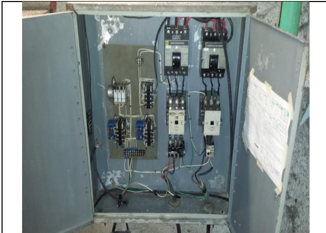
Sustitución de tablero de control y fuerza
