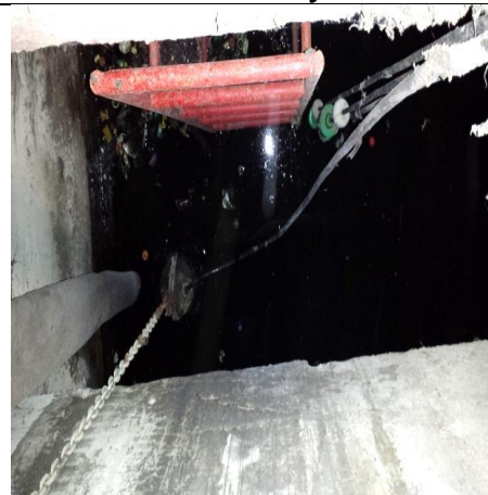
Sustitución de los cableados de alimentación trifásica a 220 volts, más un hilo de tierra, desde la subestación eléctrica hasta el tablero de control y fuerza.
