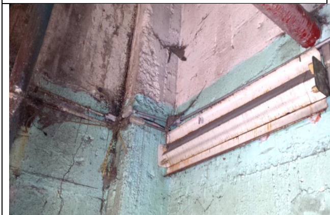
Sustitución de alumbrado, contactos apagadores, pintura general en el local
