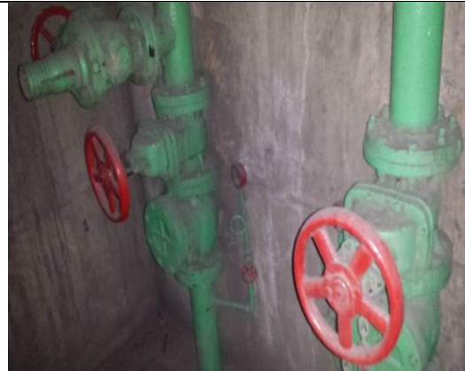
Sustitución de las tuberías de descarga y arreglo hidráulico
