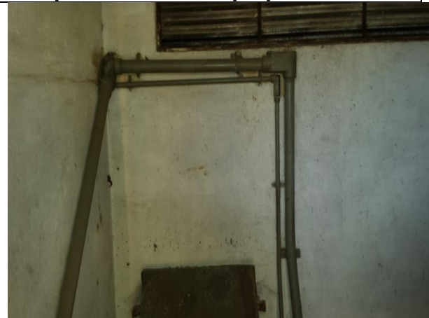
Sustitución de alumbrado ,tubería conduít, contactos, apagadores
