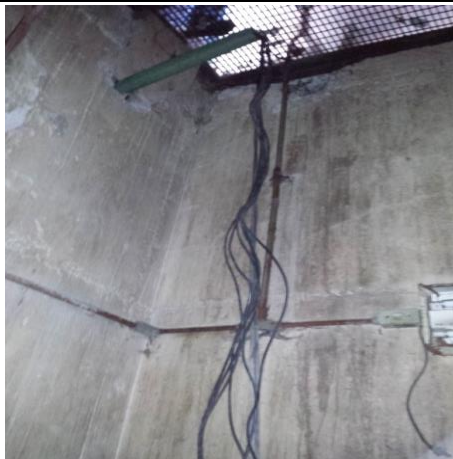
Sustitución de cableado ,tubería conduít
