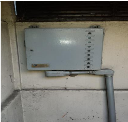
Sustitución de tablero de control y fuerza
