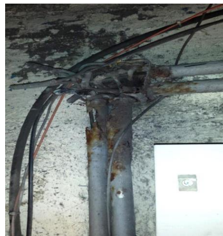
Sustitución de los cableados de alimentación trifásica a 220 volts, más un hilo de tierra, desde la subestación eléctrica hasta el tablero de control y fuerza.
