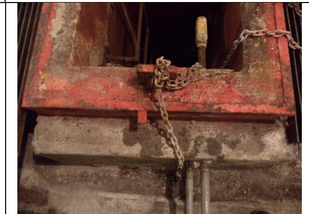
Sustituir cadenas, tuberías conduit y soportes para cadenas y electrodos.
