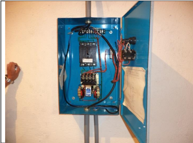
Sustitución del tablero de control y fuerza.
