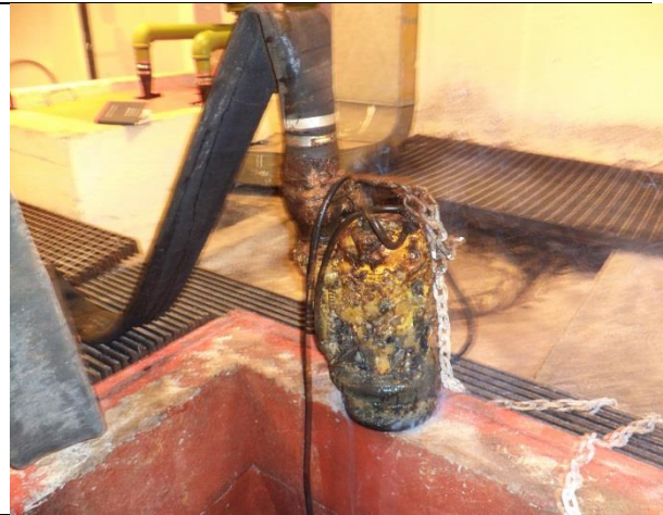
Sustitución de equipo de bombeo.
