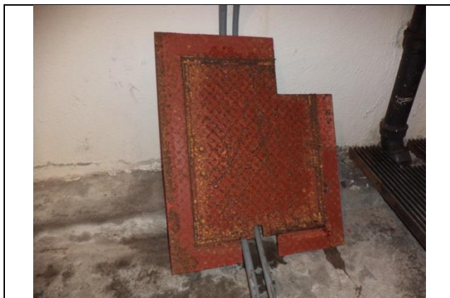
Sustituir marcos y tapas de acceso al cárcamo.
