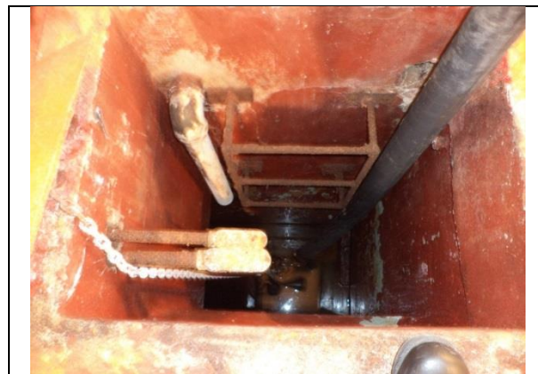
Sustitución de escalera marina de acceso al cárcamo.
