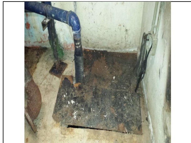
Sustitución de tapas, marco para el paso de las motobombas al cárcamo, soportería
