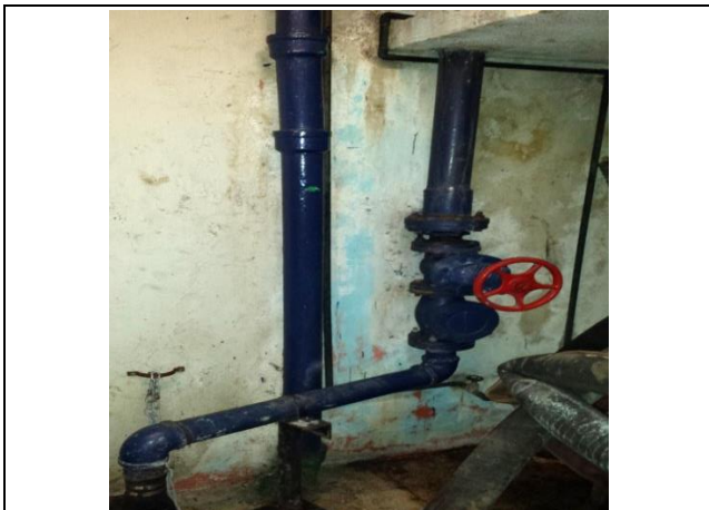
Sustitución de las tuberías de descarga y arreglo hidráulico
