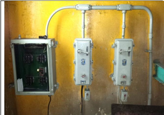
Sustitución de tablero de control y fuerza
