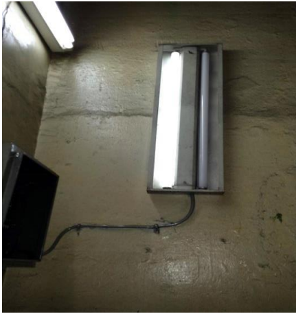
Sustitución de alumbrado, contactos, y apagadores
