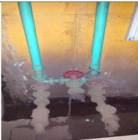
Sustitución de las tuberías de descarga y arreglo hidráulico
