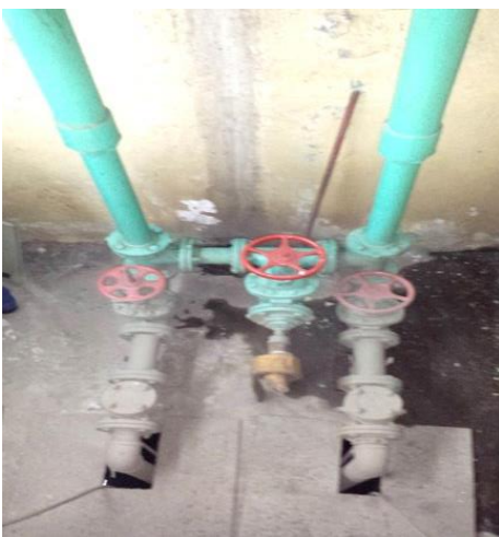
Sustitución de las tuberías de descarga y arreglo hidráulico
