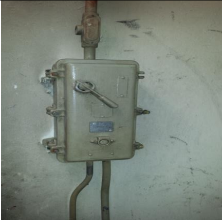
Sustitución del tablero de control y fuerza
