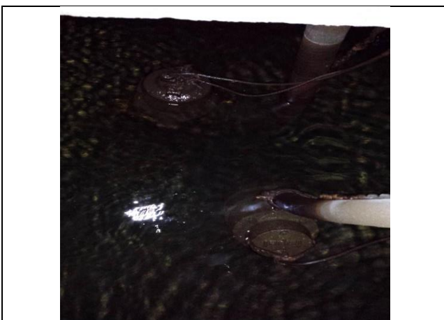
Sustitución de motobombas
