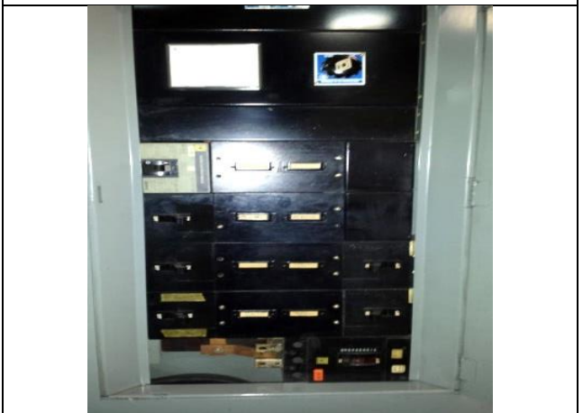
Sustitución, instalación de un tablero de distribución en donde se encuentren todos los interruptores de los equipos de bombeo de la estación "TABLERO F", con alimentación PREFERENCIAL.
