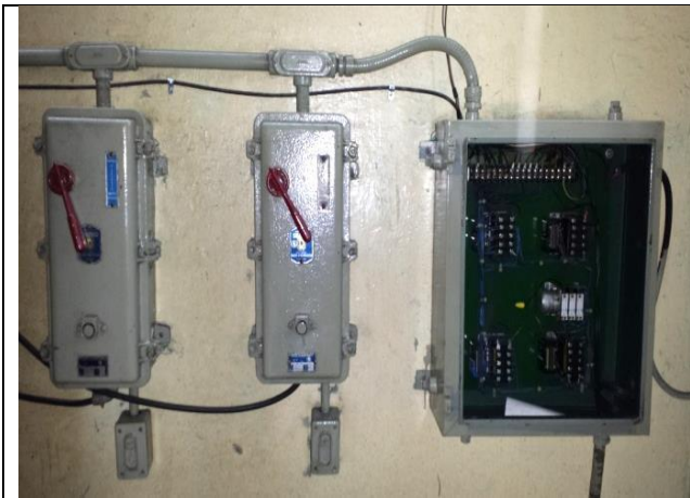
Sustitución de tablero de control y fuerza
