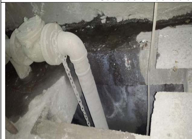
Sustitución de mangueras, cadenas, ganchos para cadena, marcos con tapa.
