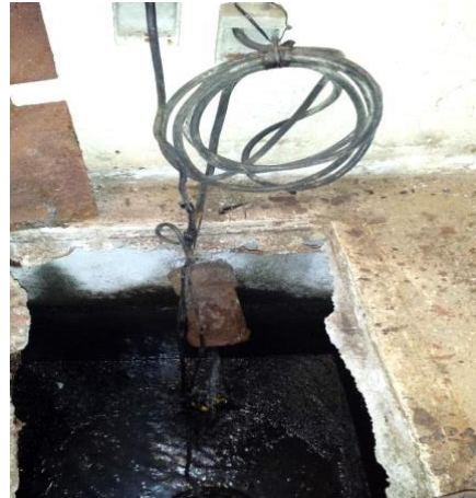
Sustituir tapa y marco del registro pasa hombre de acceso al cárcamo
