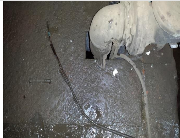
Sustitución de: mangueras; soportes para tuberías de descarga y arreglo hidráulico; tapas y marcos de registros; cadenas; ganchos para cadenas; electrodos.
