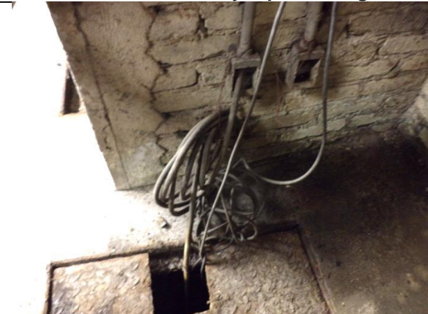
Sustitución de cableado y tuberías conduit
