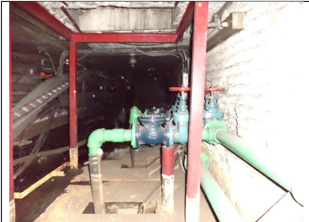
Sustitución de arreglo hidráulico y tubería de descarga
