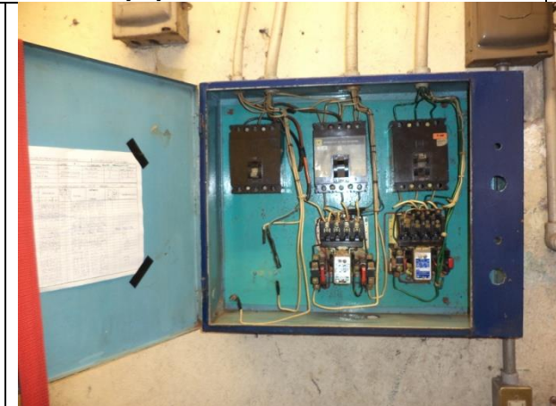
Sustitución de tablero de control y fuerza
