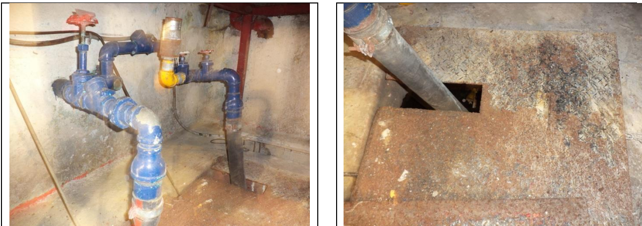
Sustitución de arreglo hidráulico, tuberías de descarga y mangueras
