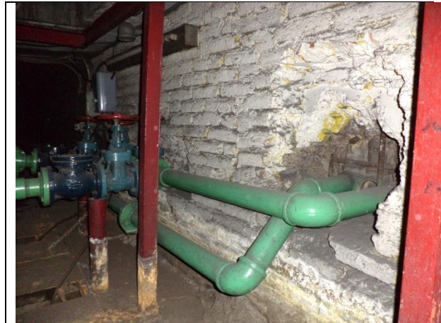
Sustitución de arreglo hidráulico y tubería de descarga
