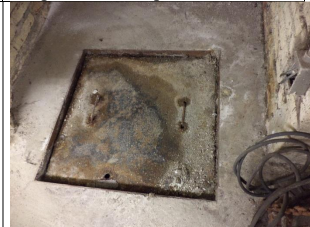
Sustitución de marcos y tapas de registro de acceso al equipo de bombeo
