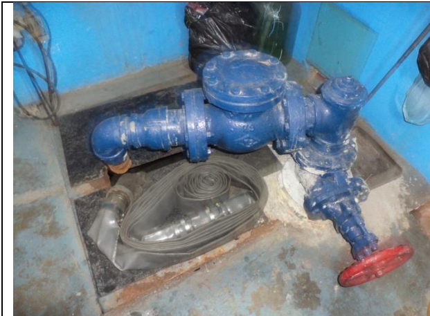
Sustitución de tuberías de descarga, arreglo hidráulico, soportería y cambio de mangueras de descarga
