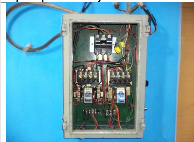
Sustituir tablero de control y fuerza
