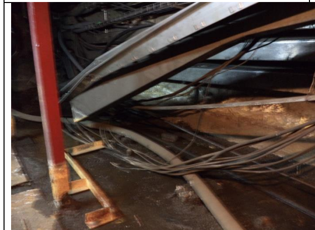
Canalización y Sustitucion de cableado de alimentacion.
