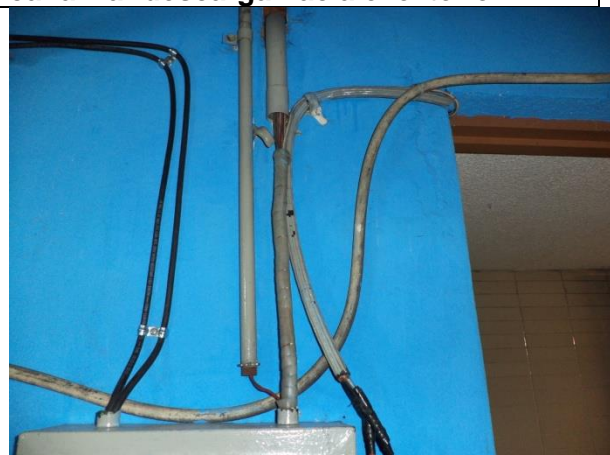
Sustituir tuberías conduit, cableado de alimentación de control y fuerza
