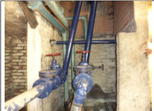
Sustitución de arreglo hidraulico y tuberías de descarga.
