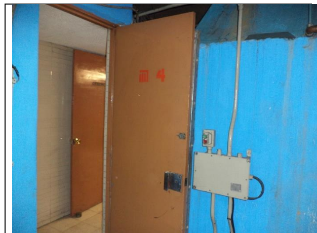
Sustitución de puerta de acceso a cárcamo
