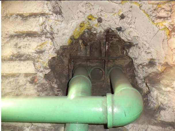
Reparacion de muro, aplanado y pintura
