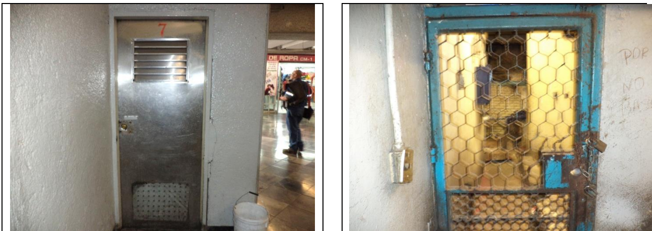
Sustitucion de las puertas de acceso a la sala de masquinas
