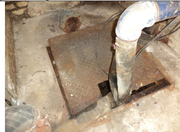
Sustitución de marcos y tapas de registro de acceso al equipo de bombeo
