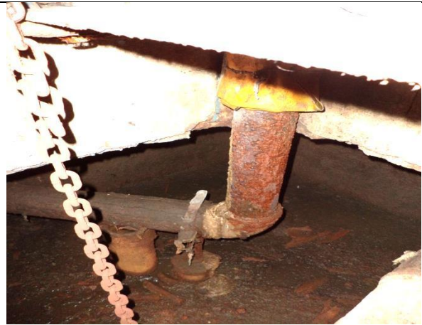
Sustitución de tuberías de descarga, arreglo hidráulico, soportería y cambio de mangueras de descarga
