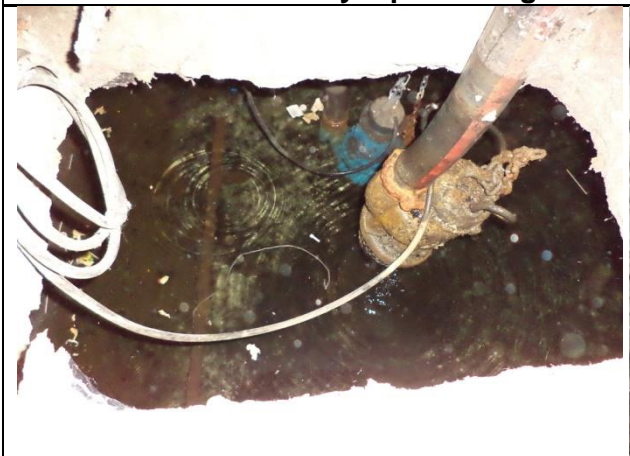
Sustitución de motobombas
