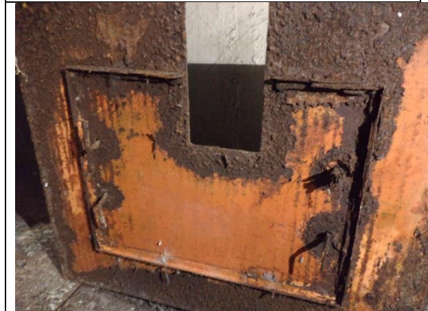
Sustitución de marcos y tapas de registro de acceso del equipo de bombeo.
