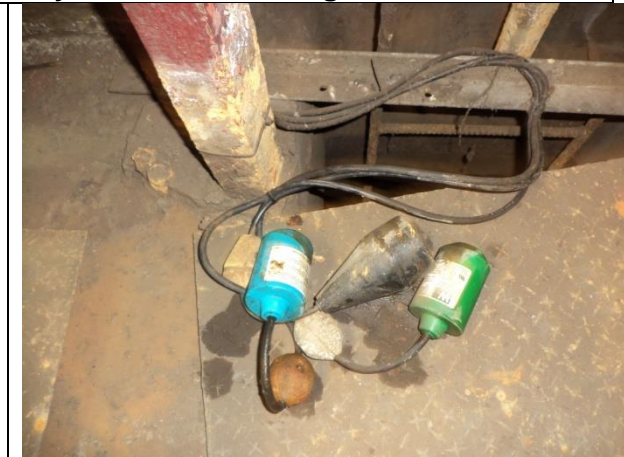
Sustitucion de electroniveles por electrodos de acero inoxidable.
