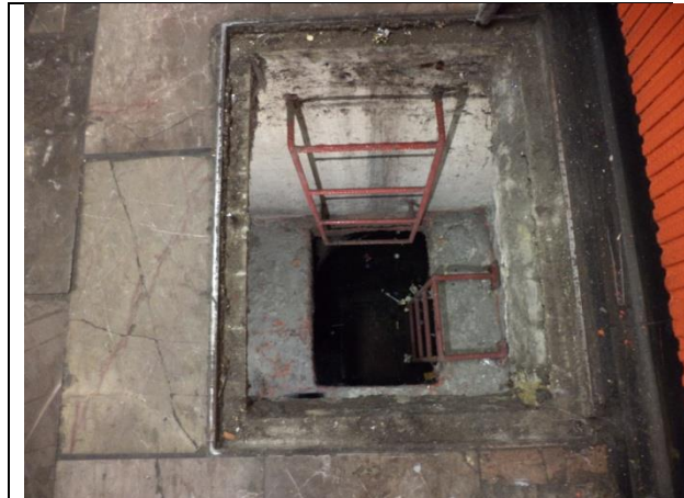
Sustitución tapas, marcos de registros, y escaleras de acceso al registro desde nivel andén al bajo andén y del bajo andén al interior del cárcamo
