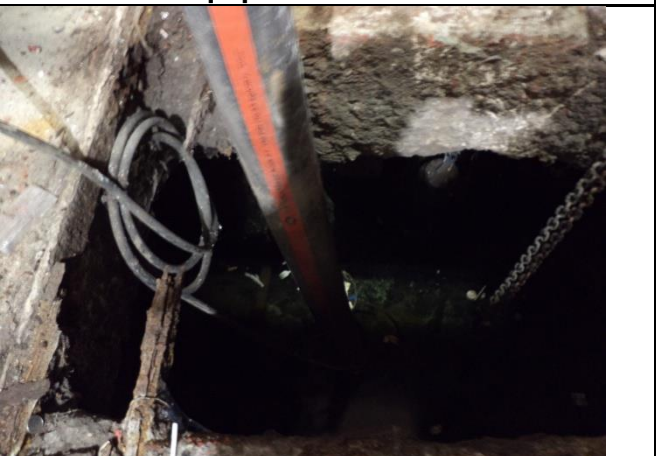
Instalación de soportes para el cableado de control, cables de motobombas y cadenas
