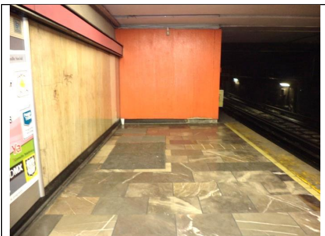
Sustitucion de marcos y tapas de acceso al carcamo.
