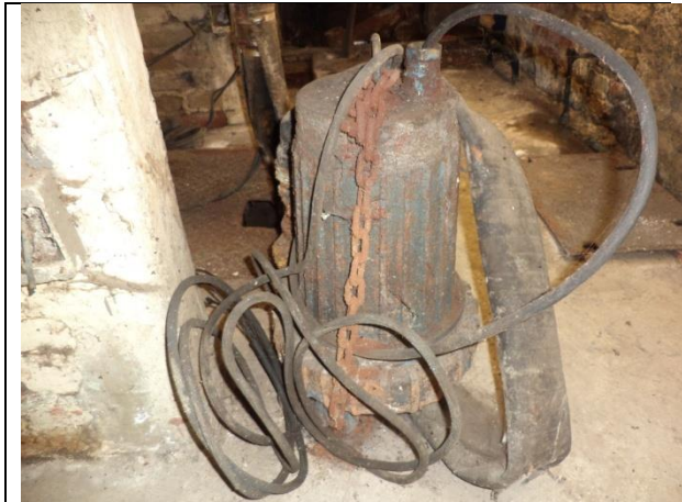
Sustitucion de equipo de bombeo, manguera de descarga.
