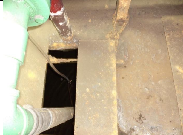
Sustitución de marcos y tapas de registros de acceso del equipo de bombeo y soporte para cadena y electrodos.
