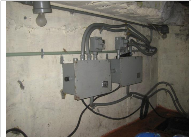
Sustitución de tablero de control y fuerza
