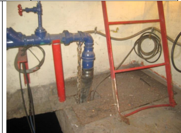
Colocación de ganchos fabricados en acero inoxidable, para los electrodos, cables de motobombas y cadenas.
