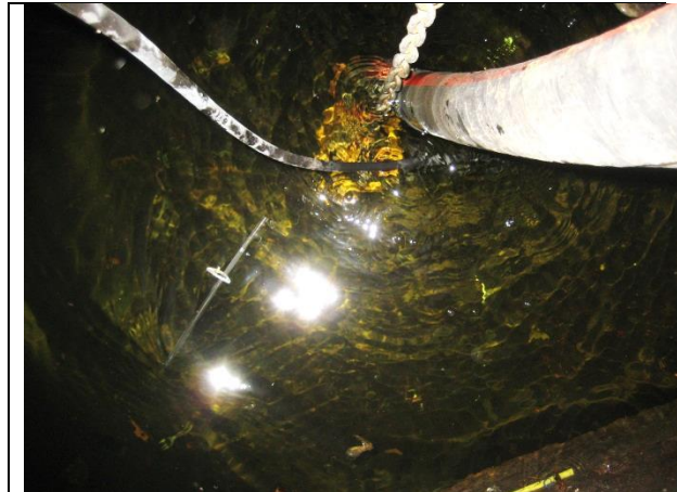
Sustitución de motobombas
