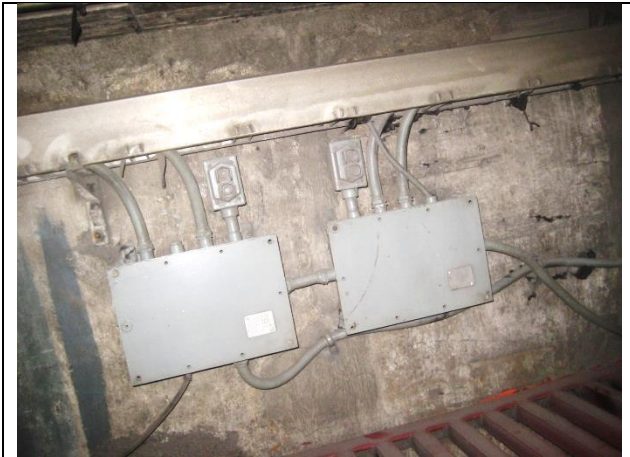
Sustitución del tablero de control y fuerza
