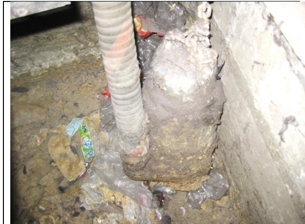
Sustitución de las dos motobombas
