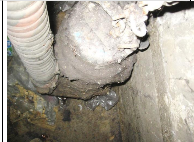
Sustitución de mangueras, cadenas, soportería, electrodos de acero inoxidable, rejilla y marco del cárcamo.
