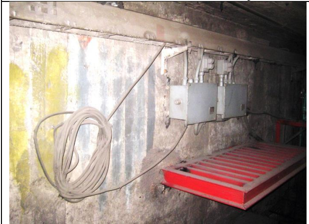
Instalación de tuberías conduit en la sala de máquinas para los cableados de fuerza y control y sustitución de cableados desde la subestación eléctrica
