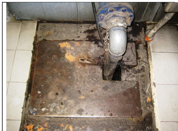
Sustituir tapa y marco del registro para las maniobras con el equipo de bombeo,
