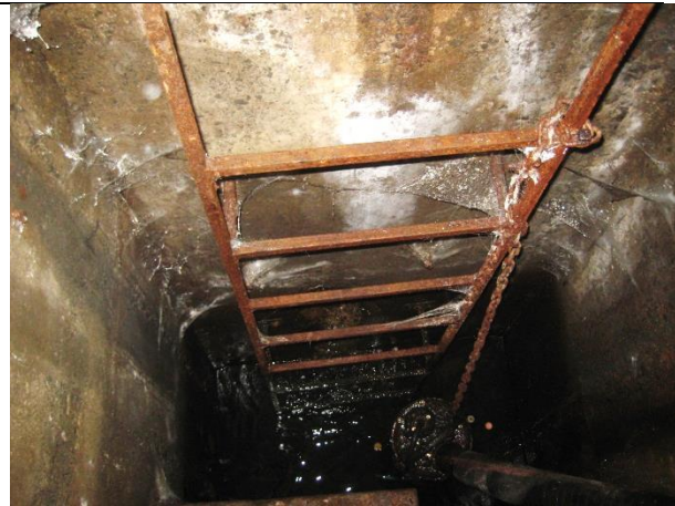
Sustitución de escalera marina, tapa y marco de acceso al cárcamo
