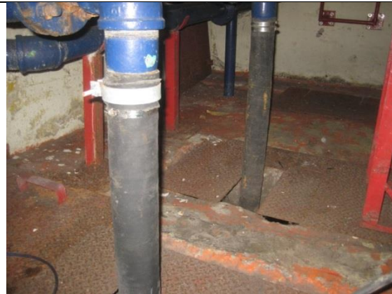
Sustitución de: mangueras; soportes para tuberías de descarga y arreglo hidráulico; tapas y marcos de registros
