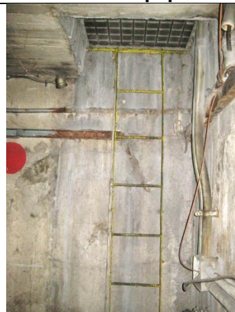
Sustitución de escalera marina, instalando escalera tipo rampa fabricada con rejilla Irving en los escalones
