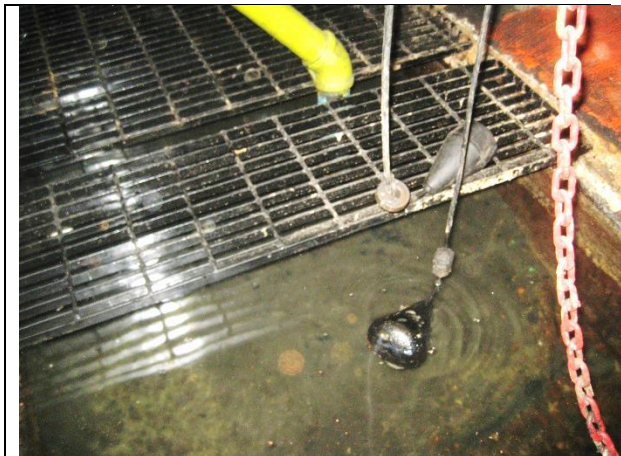
Sustitución de rejilla Irving y marco soporte del cárcamo, instalación de electrodos de acero inoxidable y cadena para maniobras del equipo de bombeo.
