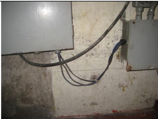
Instalación de tuberías conduit para los cables de fuerza y control
