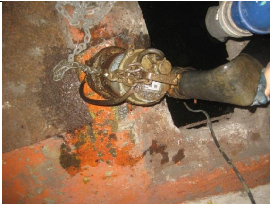
Sustitución de motobombas y cadenas
