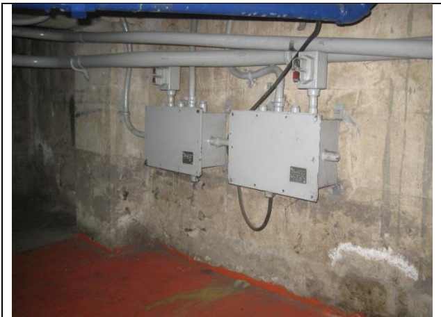
Sustitución del tablero de control y fuerza
