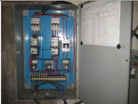
Sustitución de tablero de control y fuerza
