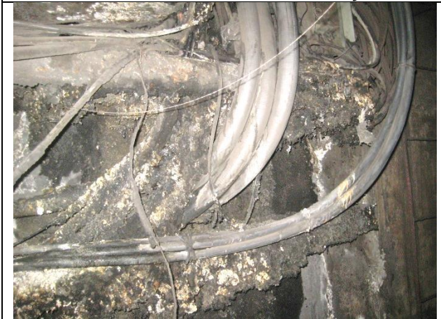
Instalación de tuberías conduit en la sala de máquinas para los cableados de fuerza y control y sustitución de cableados desde la subestación eléctrica
