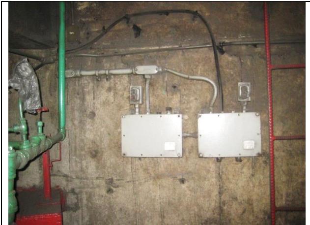
Sustitución del tablero de control y fuerza
