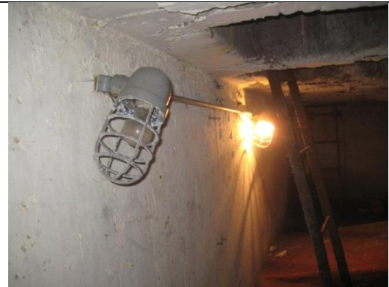
Sustitución de alumbrado y tuberías conduit
