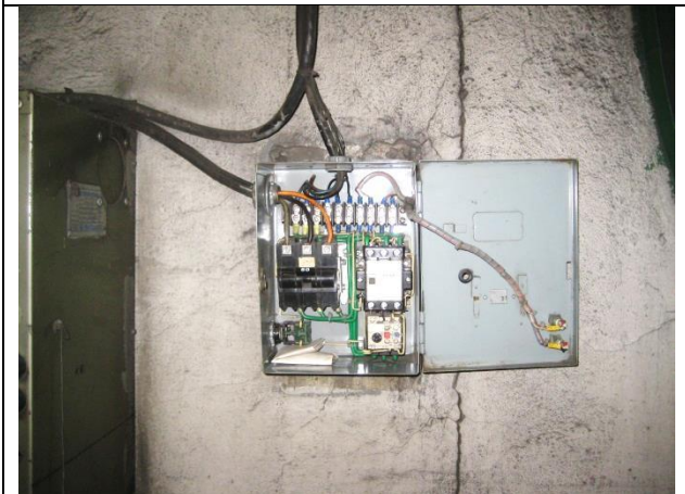
Sustitución del tablero de control y fuerza
