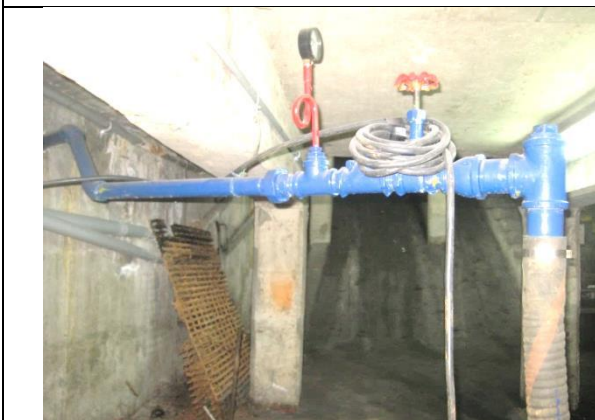
Instalación de tuberías conduit en la sala de máquinas para los cableados de fuerza y control
