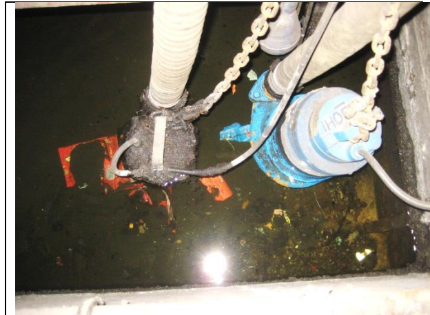
Sustitución de las dos motobombas
