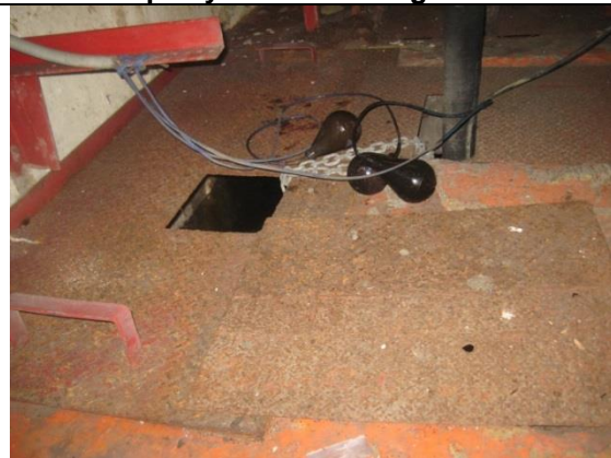
Instalación de electrodos en acero inoxidable, cadenas y soportes
