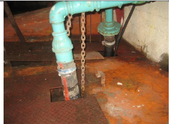
Sustitución de: mangueras; soportes; tapas y marcos de registros
