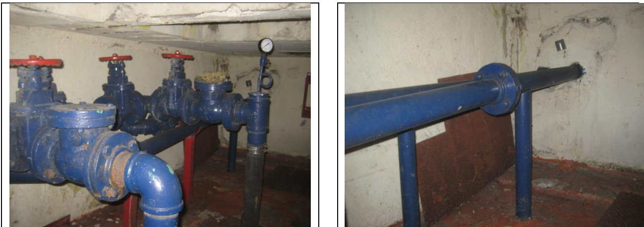
Sustitución de las tuberías de descarga y arreglo hidráulico
