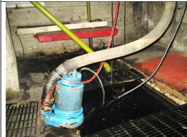
Sustitución de las dos motobombas
