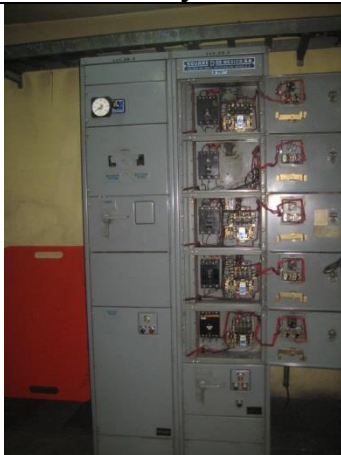
Sustitución del centro de control de motores y transferencia automática en la subestación eléctrica, instalando un tablero de distribución en donde se encuentren todos los interruptores de los equipos de bombeo de la estación "TABLERO F", con alimentación PREFERENCIAL.
