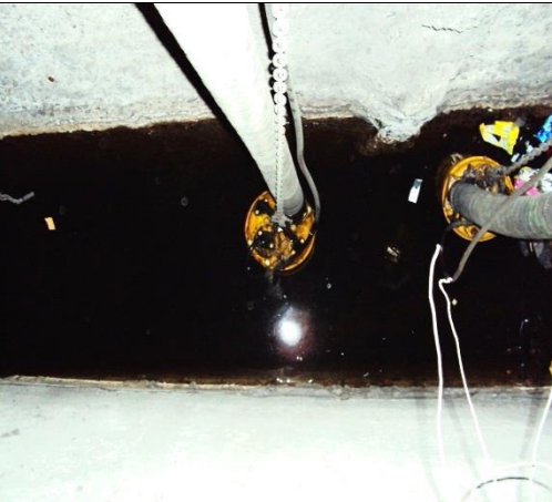
Sustitución de las motobombas
