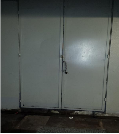
Sustitución de la puerta de acceso a la sala de maquinas
