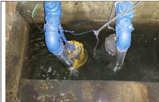
Sustitución de las motobombas
