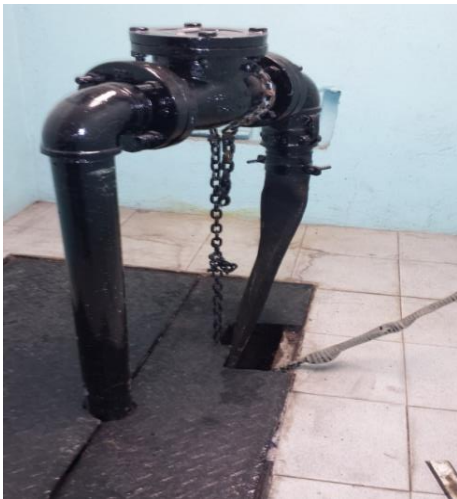
Sustitución de las tuberías de descarga y arreglo hidráulico
