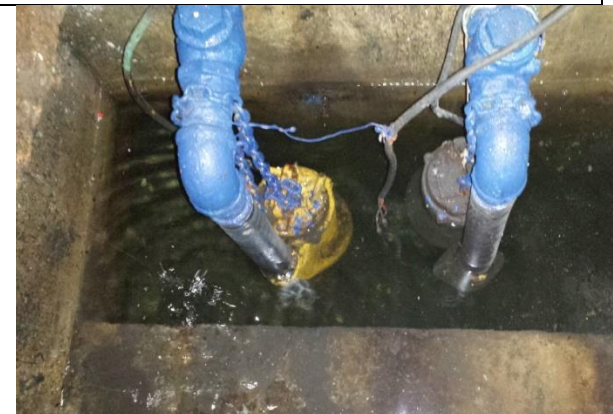
Sustitución de electrodos, instalando electrodos en acero inoxidable
