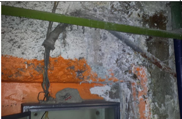
Sustitución de las tuberías conduit.
