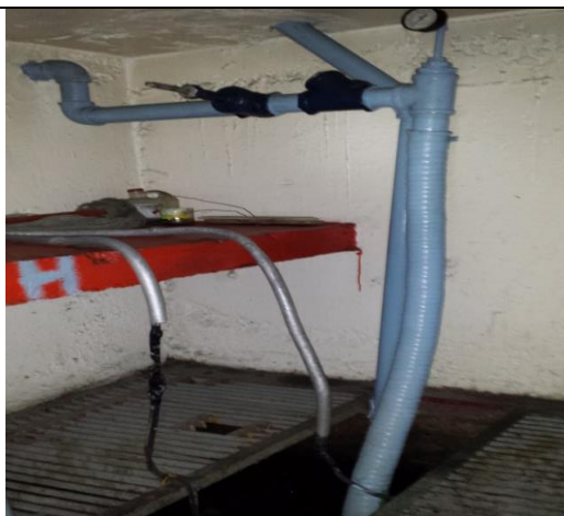
Sustitución de las tuberías de descarga y arreglo hidráulico
