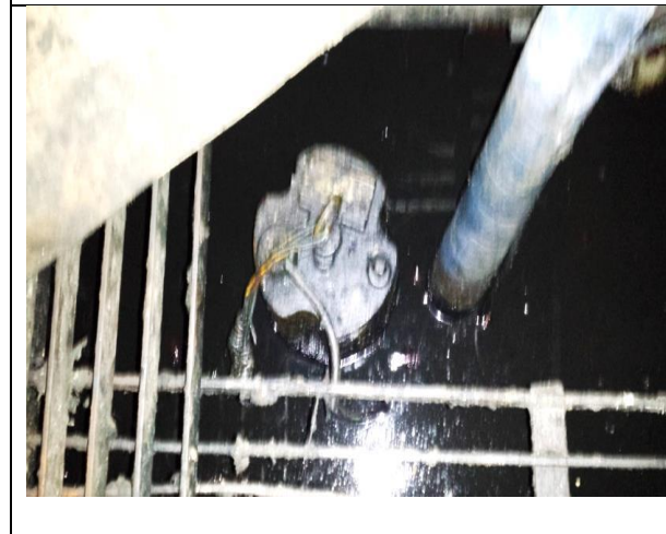
Sustitución de motobombas
