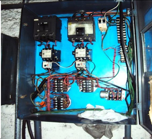
Sustitución del tablero de control y fuerza
