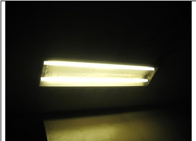
Instalación de 7 gabinetes de 2 x 32
