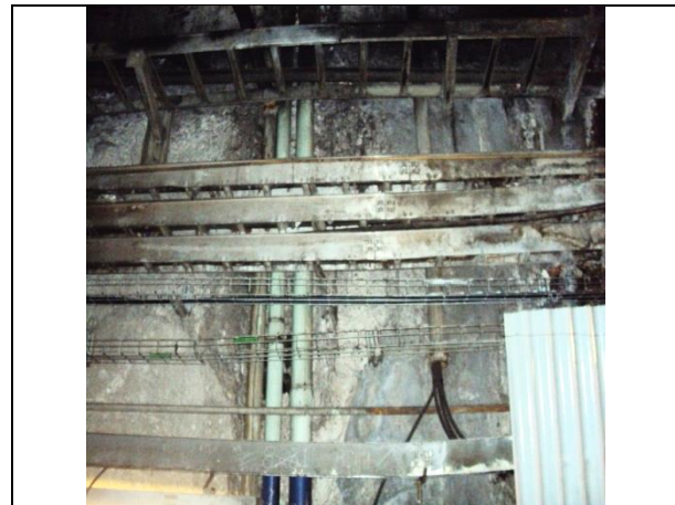
Sustitución de las tuberías de descarga
