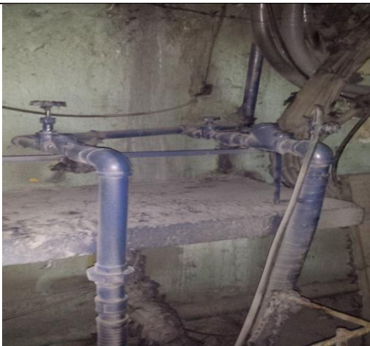
Sustitución de las tuberías de descarga y arreglo hidráulico
