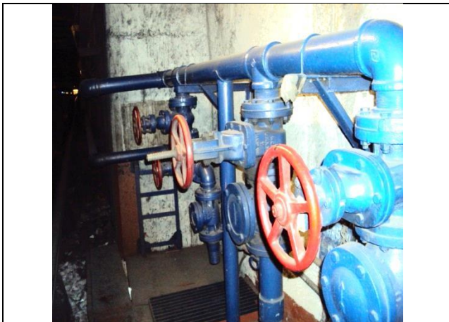
Sustitución de las tuberías de descarga
