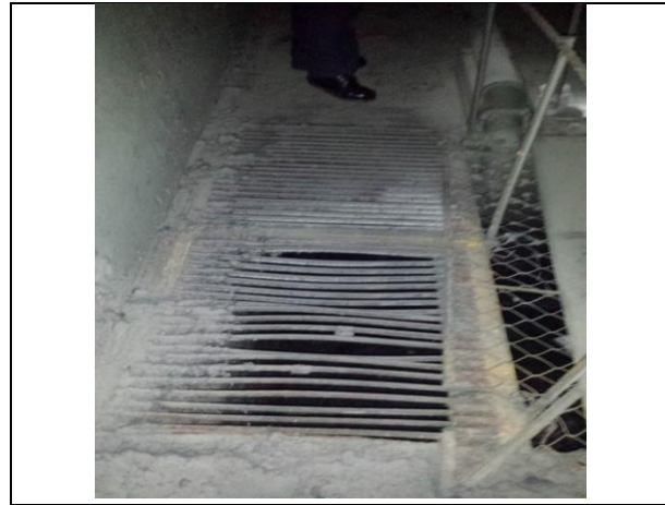
Sustitución de marcos y rejillas Irving en el cárcamo
