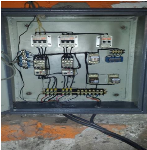
Sustitución del tablero de control y fuerza
