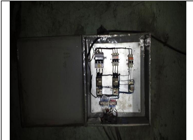
Sustitución de tablero de control y fuerza
