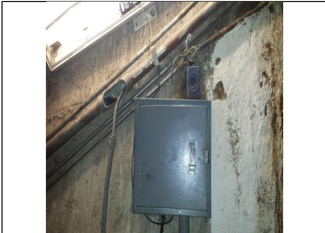
Sustitución de tablero de control y fuerza
