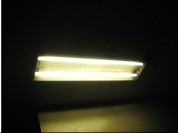
Instalación de 7 gabinetes de 2 x 32 W
