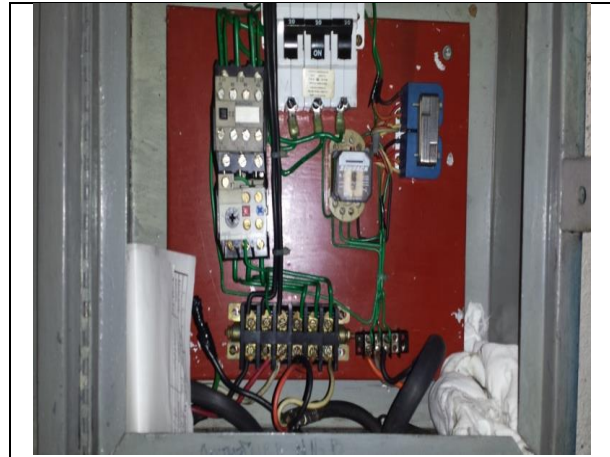
Sustitución de tablero de control y fuerza
