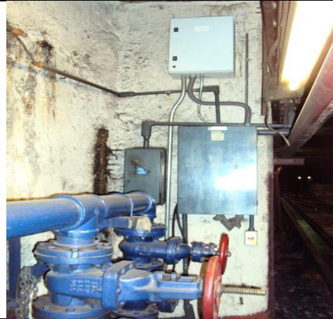
Sustitución de las tuberías conduit
