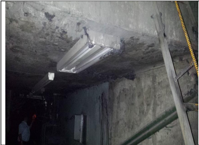
Instalación de 7 gabinetes de 2 x 32 W
