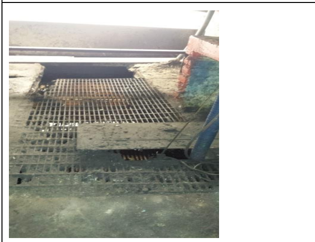
Sustitución de marcos y rejillas irving
