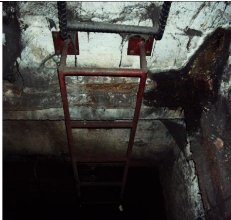
Sustitución de la escalera marina
