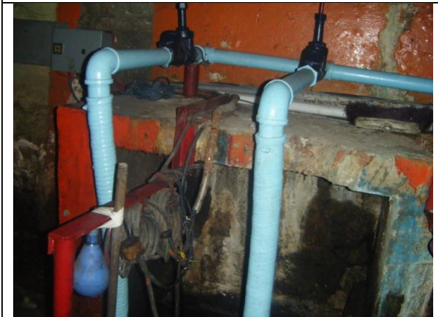
Sustitución de tablero de control y fuerza
