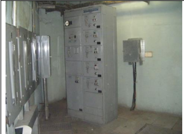
Sustitución del centro de control de motores y transferencia automática en la subestación eléctrica, instalando un tablero de distribución en donde se encuentren todos los interruptores de los equipos de bombeo de la estación "TABLERO F", con alimentación PREFERENCIAL.
