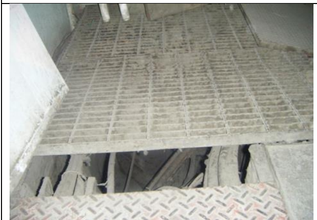
Sustitución de los cableados de alimentación
