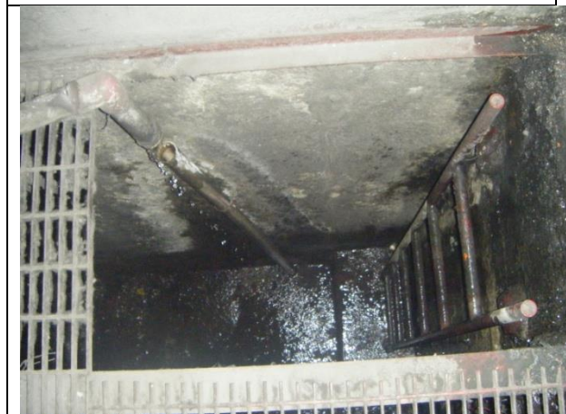
Instalación de escalera de acceso de nivel anden al cuarto de máquinas del extractor y
