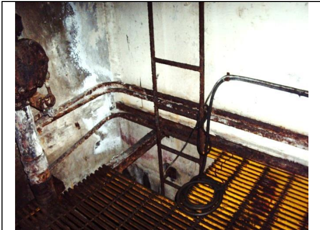
Sustitución de escalera marina
