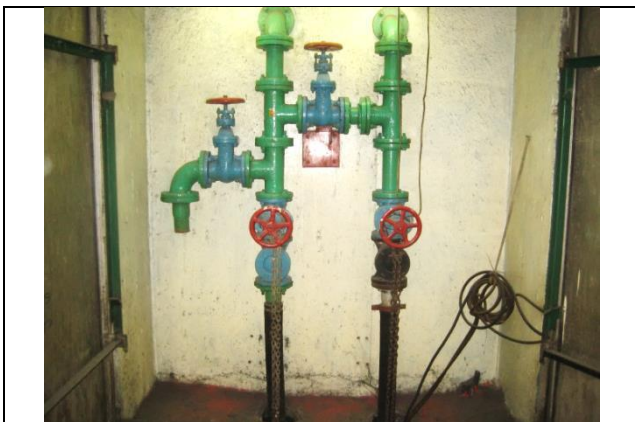
Sustitución de las tuberías de descarga y arreglo hidráulico
