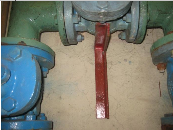
Sustitución de soportería en arreglo hidráulico y tuberías de descarga.
