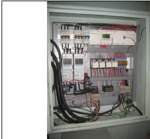
Sustitución del tablero de control y fuerza
