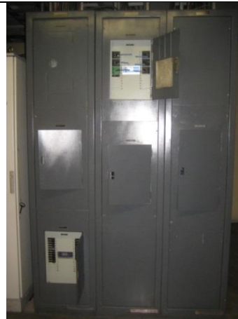
Sustitución del tablero de distribución eléctrica en la subestación "TABLERO F".
