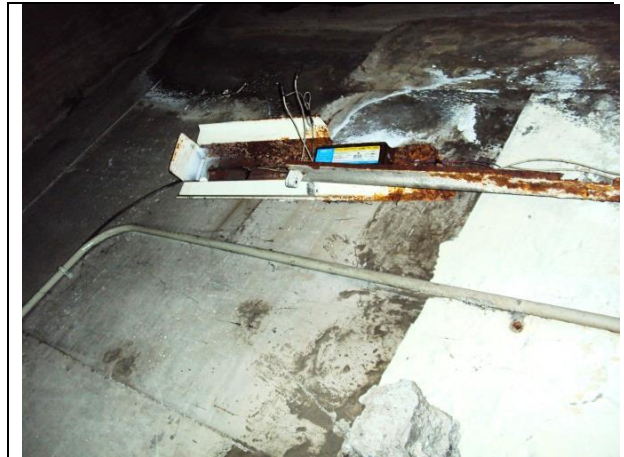
Sustitución del sistema de alumbrado: instalando lámparas ahorradoras de energía
