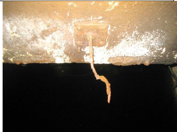
Sustitución de gancho para electrodos y cadenas
