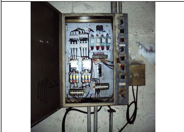
Sustitución de tablero de control y fuerza y tuberías conduit, para alojar cables de fuerza y control.
