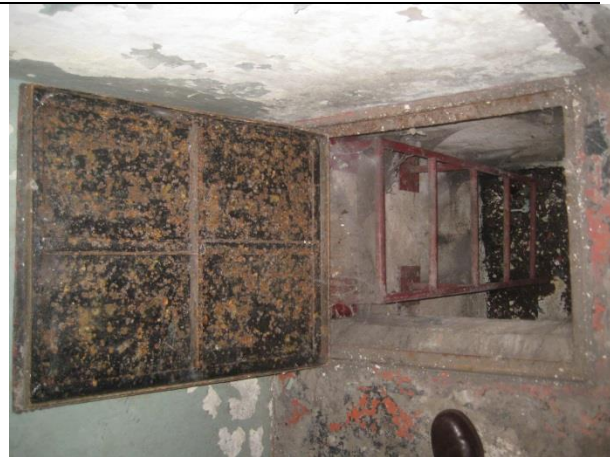
Sustitución de escaleras marinas, instalando escaleras fabricada en acero inoxidable.
