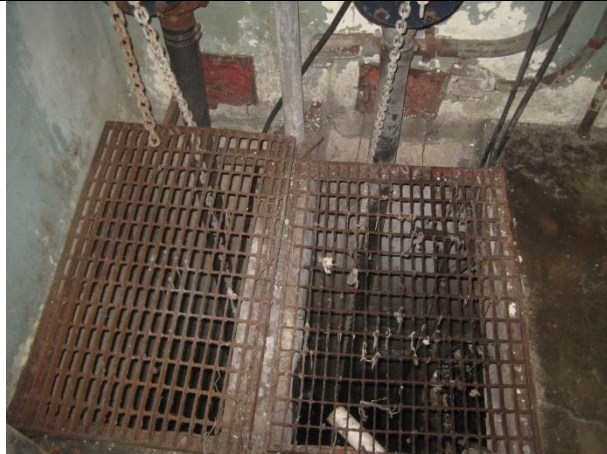
Sustituir rejilla irving y marcos de paso de motobombas al cárcamo
