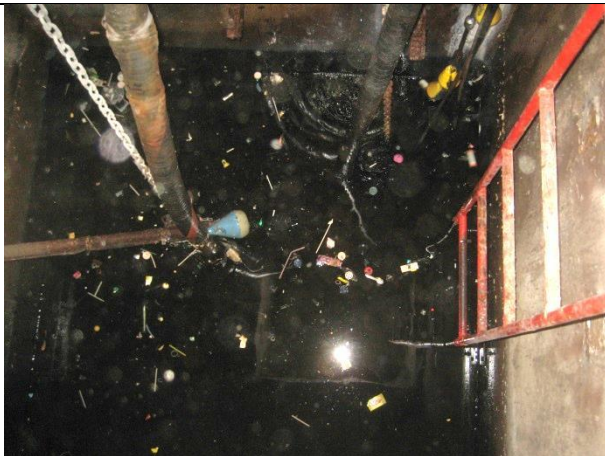
Instalación de escalera marina, instalando escaleras fabricada en acero inoxidable.
