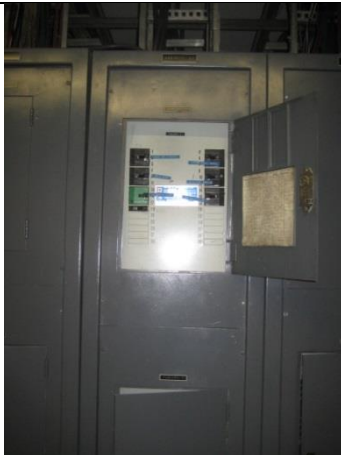
Sustitución del tablero de distribución eléctrica en la subestación "TABLERO F".
