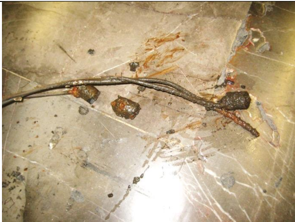
Sustitución de electrodos, instalando electrodos en acero inoxidable.
