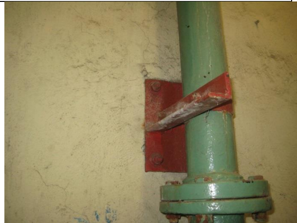
Sustitución de soportería en arreglo hidráulico y tuberías de descarga.
