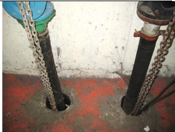
Sustitución de cadenas para las maniobras con las motobombas
