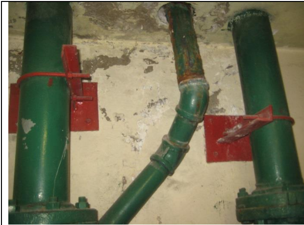
Sustitución de soportes en arreglo hidráulico y tuberías de descarga
