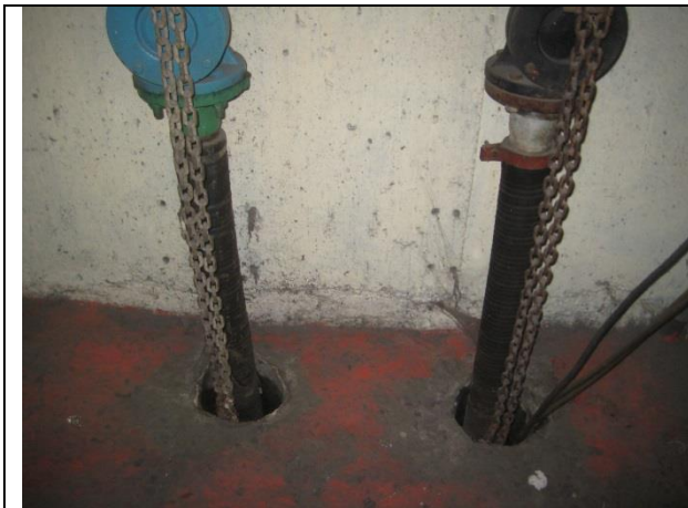
Sustitución de mangueras de descarga de 3" de diámetro
