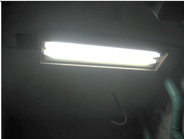
Instalación de gabinetes de alumbrado (2 gabinetes de 2 x 32 W.)
