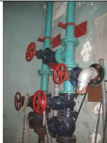
Sustitución de cadenas para las maniobras con las motobombas
