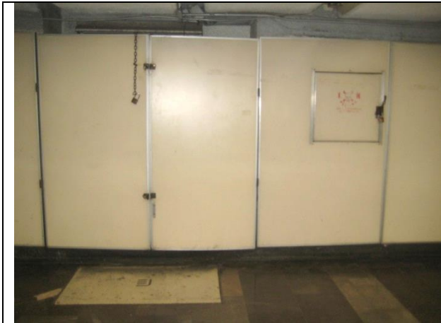
Sustitución de la puerta de acceso a la sala de maquinas
