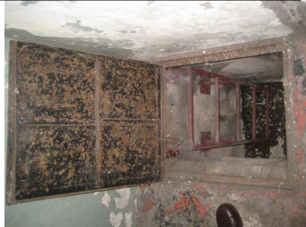
Sustituir tapa y marco del registro pasa hombre de acceso al cárcamo
