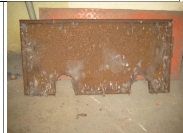
Sustituir tapas y marco del registro de acceso al cárcamo
