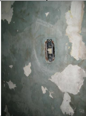
Sustitución de apagador y contacto.
