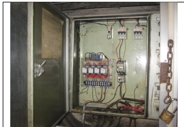
Sustitución del tablero de control y fuerza
