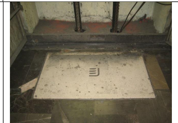
Sustituir tapas y marco del registro de acceso al cárcamo
