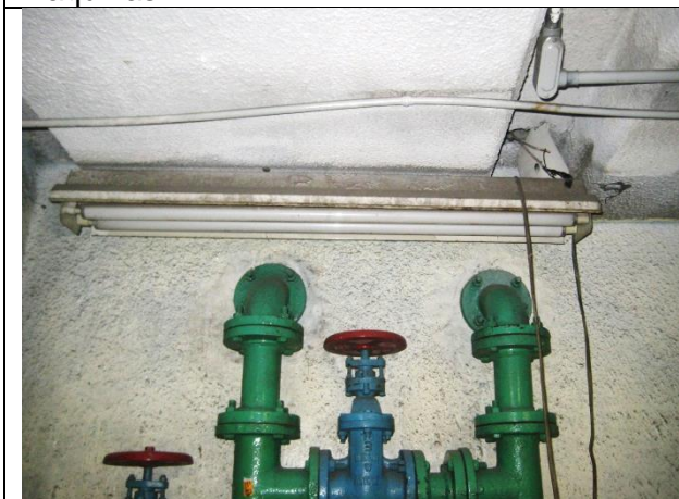
Sustitución de gabinete de alumbrado e instalación de apagador y contactos
