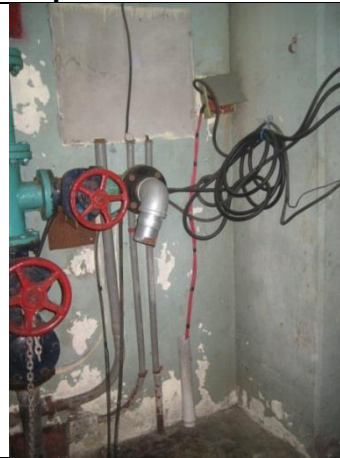
Sustitución de las tuberías conduit.
