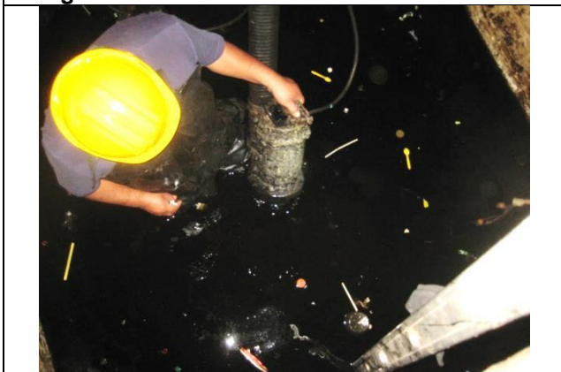
Sustitución de las dos motobombas
