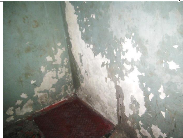
Aplicación de pintura en general a la sala de máquinas
