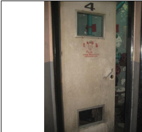
Sustitución de la puerta de acceso a la sala de maquinas
