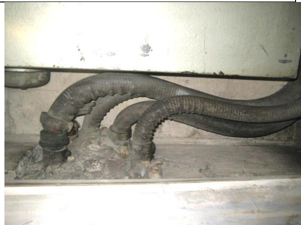
Sustitución de las tuberías conduit.
