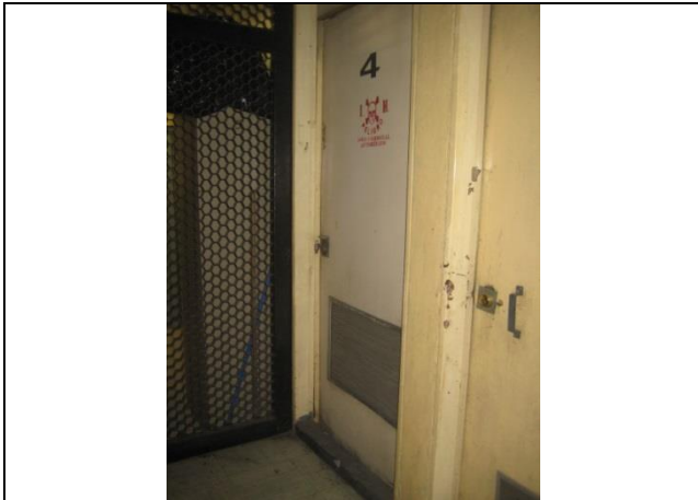
Sustitución de la puerta de acceso a la sala de maquinas
