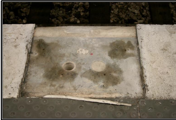
Figura 12. Imagen de receso sobre el andén para preparar el montaje (imagen no contractual)
