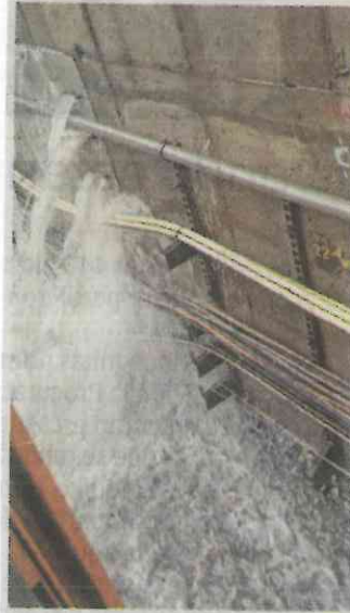
El agua se filtró en las vías del Metro, se suspendieron actividades en cinco estaciones.
