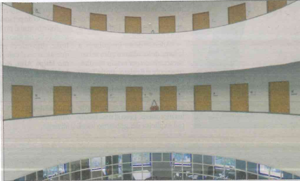
"Todo el Cenart está catalogado como edificio artístico pero no hubo daño estructural y sólo se trabajó la renovación de acabados, además corresponde al siglo XX", dijo el subdirector general de educación e investigación artística del INBA.
