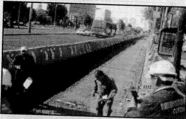
Presentan obras de Línea 7 del Metrobús, avance significativo.
