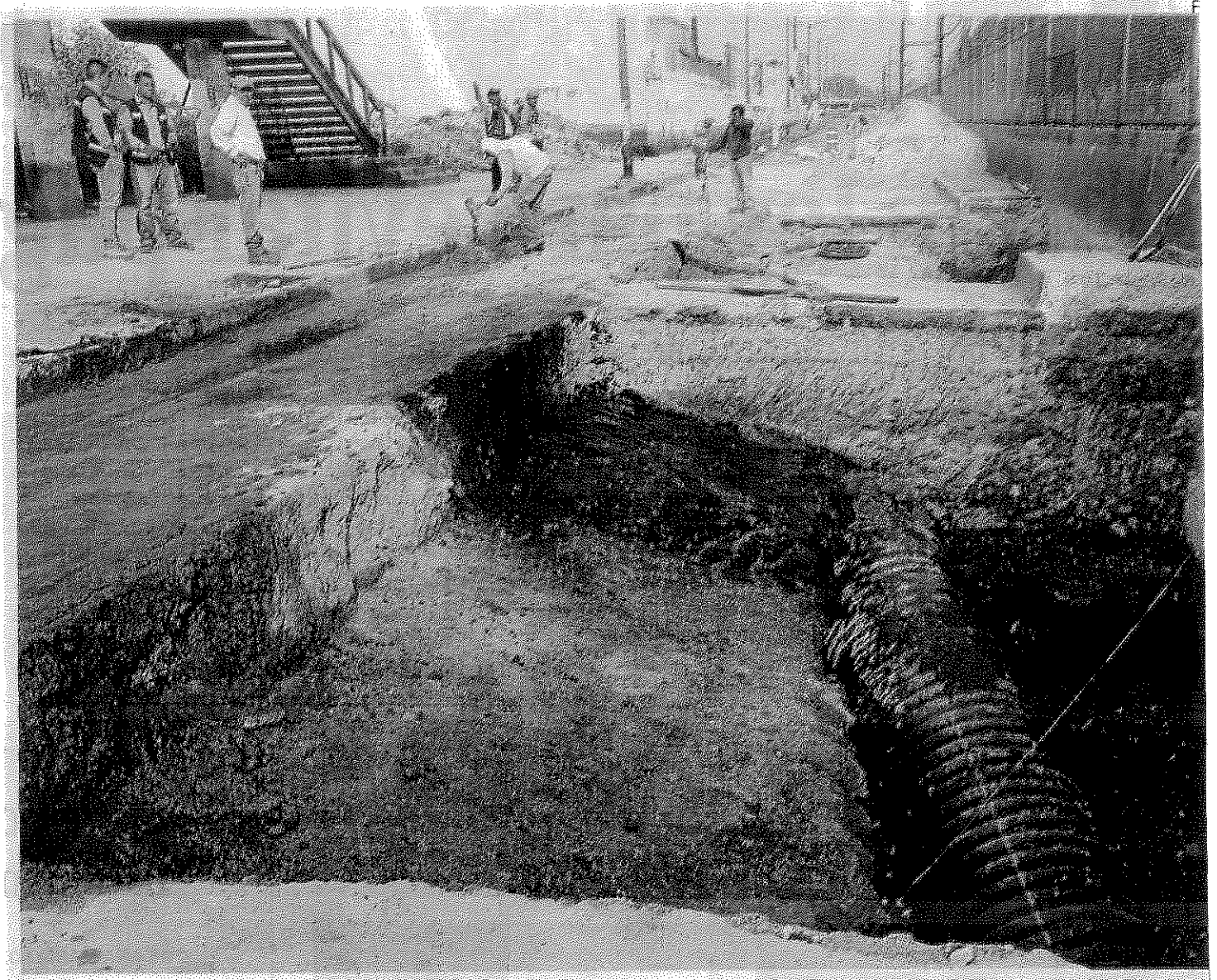
EL COLECTOR que cuenta solo con un kilómetro cien metros de extensión, tiene tubería de 4.22 metros de alta densidad, y requirió una inversión de 24 millones de pesos, estará concluida a finales de junio
