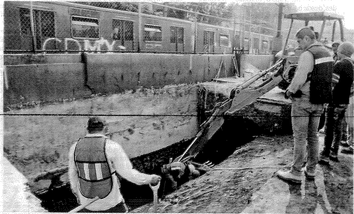
Trabajos profundos. Las obras del Metro evitarán que las lluvias afecten el servicio en la Línea A, que cruza los límites entre la Ciudad de México y el EDOMEX. / DANIEL PERALES
