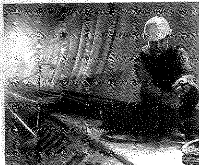
EN LA OBRA se han utilizado 530 toneladas de acero.
